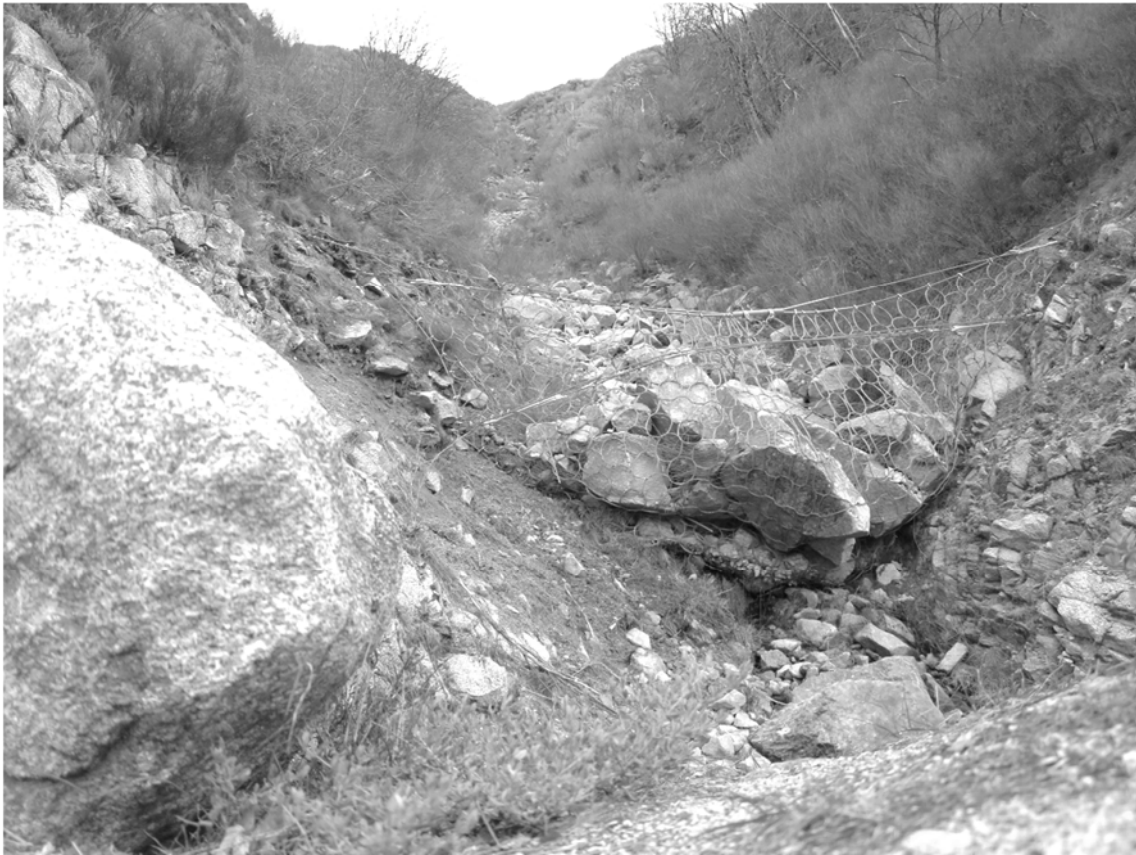
Figura 42 - Vedação metálica EN338 no vale do Zêzere.
