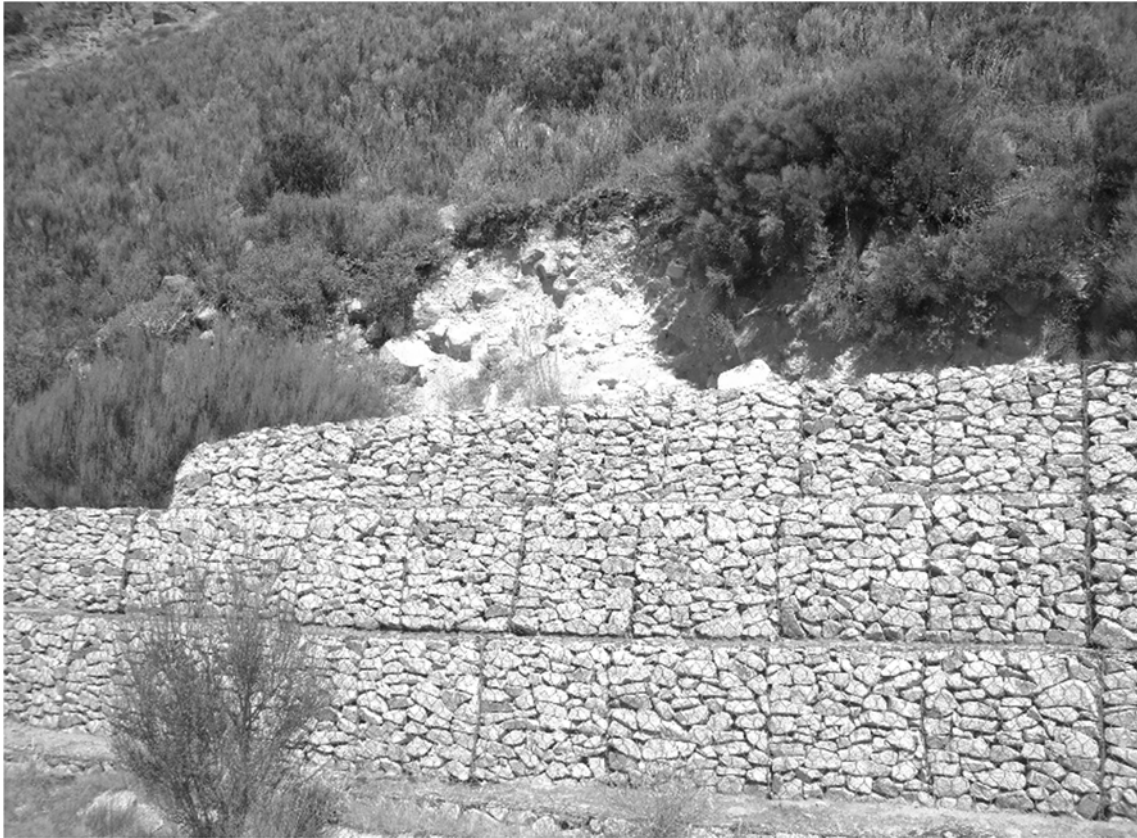
Figura 40 - Muro de Gabiões na estrada que liga a Nave de S. António a Unhais da Serra.
