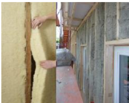
Figura 9: Manto em lã de ovelha aplicado na construção de edifícios
