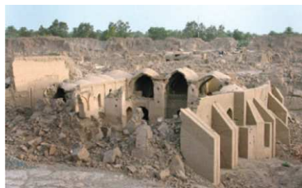
Figura 2.15 - Colapso de construções de adobe, sismo de Bam, 26 de Dezembro 2003, Irão, [Isik, 2006]
