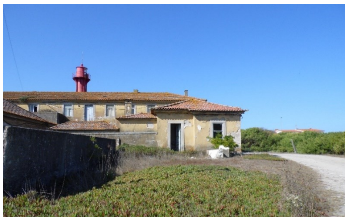
Figura 22 - Edifícios adjacentes ao farol, no seu estado atual.
