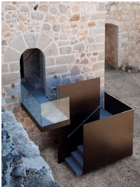
Figura 36 - Escadaria de acesso em aço corten.
