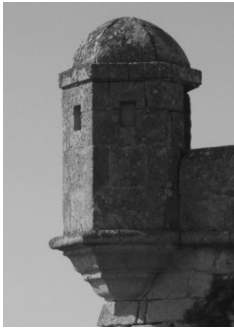
Figura 3 - Guarita existente no Forte de São João Batista de Esposende Fonte: Fotografia retirada pelo autor
