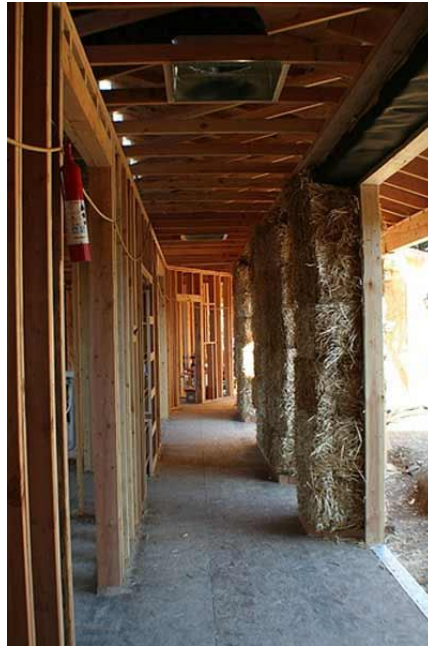
Figura 60 - Edificação executada com elementos estruturais 75
