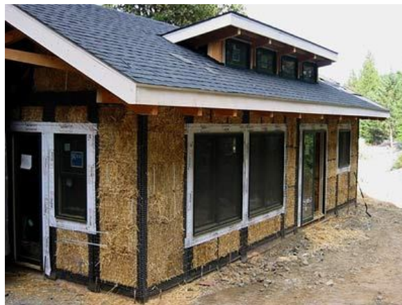
Figura 63 - Estabilização das paredes com perfis metálicos 76
