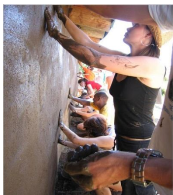
Figura 44 - Colocação de reboco de barro na parede 60
