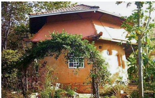
Figura 57 - Edificação executada em Cob 72
