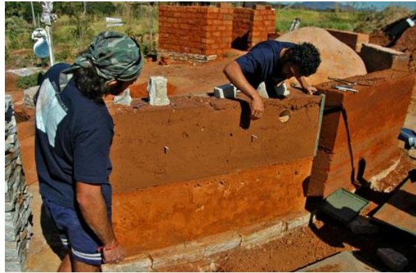
Figura 49 - Fundação em alvenaria de pedra 64
