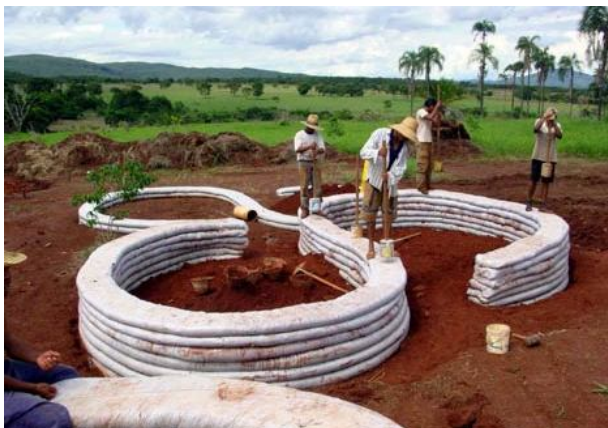
Figura 39 - Compactação com o pilão 57
