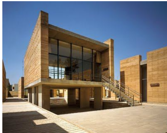
Figura 52 - Edificação em taipa de pilão 67
