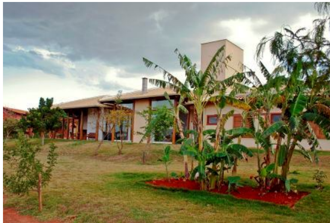
Figura 82 - Tanques de biorremediação - Aspecto exterior 93
