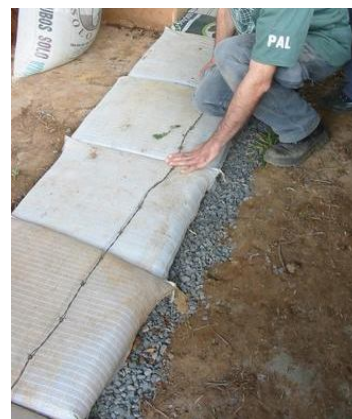
Figura 40 Colocação do arame farpado 58
