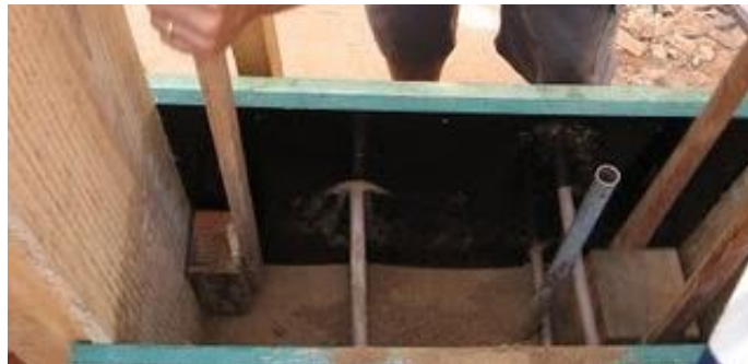
Figura 50 - Ancoramento do taipal 65
