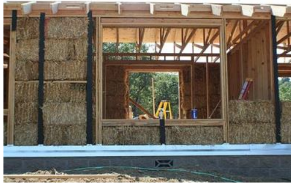
Figura 62 - Armações de madeira, para execução de vãos 76
