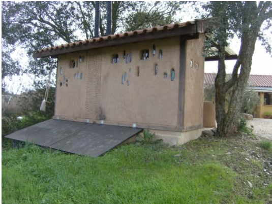
Figura 76 - Comportas de acesso à câmara de compostagem (Eco-Aldeia Tâmera) 89
