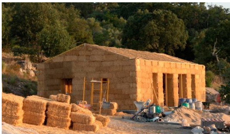
Figura 59 - Edificação executada com fardos de palha estruturais 74
