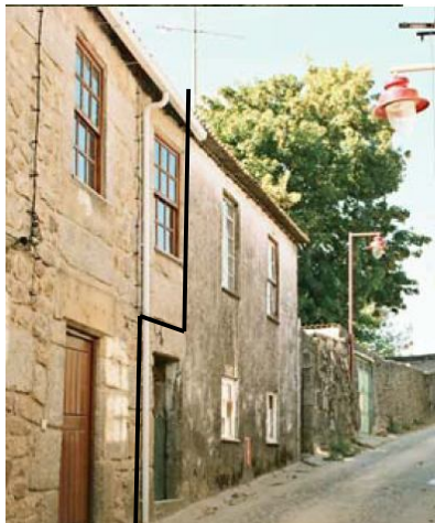
Figura 97 - Acesso ao piso inferior
