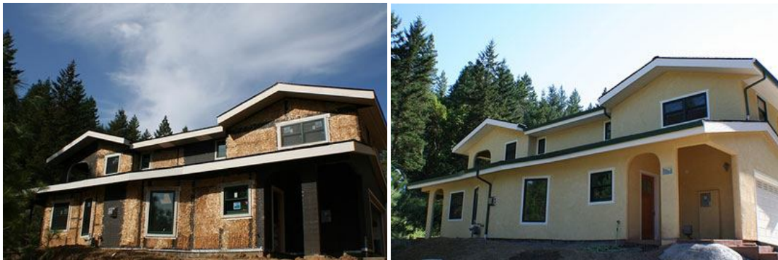
Figura 65 - Edificação executada com fardos de palha, antes e depois do acabamento 78
