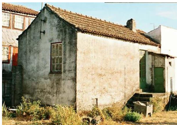
Figura 98 - Acesso ao piso superior
