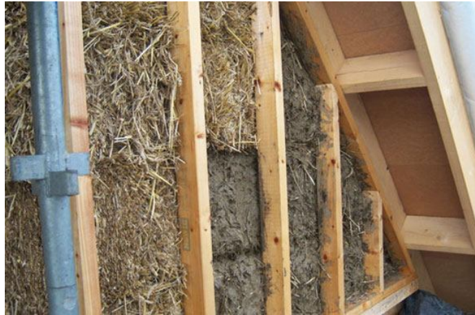
Figura 64 - Aplicação do reboco sobre os fardos de palha 77
