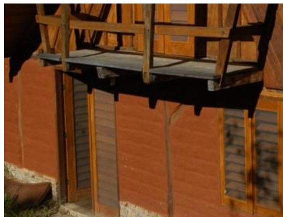
Figura 67 - Acabamento final com reboco natural 80
