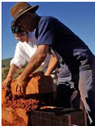
Figura 36 - Levantamento de parede em tijolos de adobe 54
