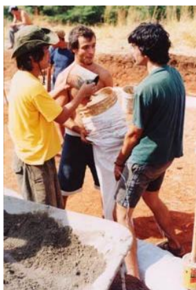
Figura 37 - Enchimento dos sacos de polipropilenos com terra crua 55
