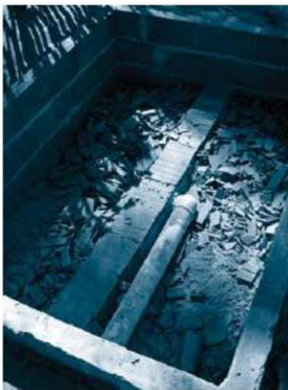
Figura 80 - Tanques de biorremediação - fase de construção 92
