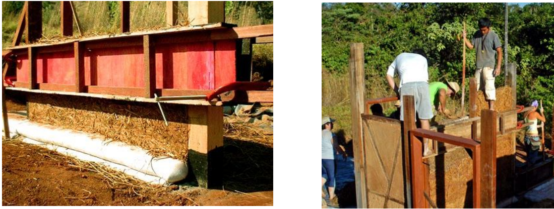
Figura 46 - Execução da parede em taipa leve 62
