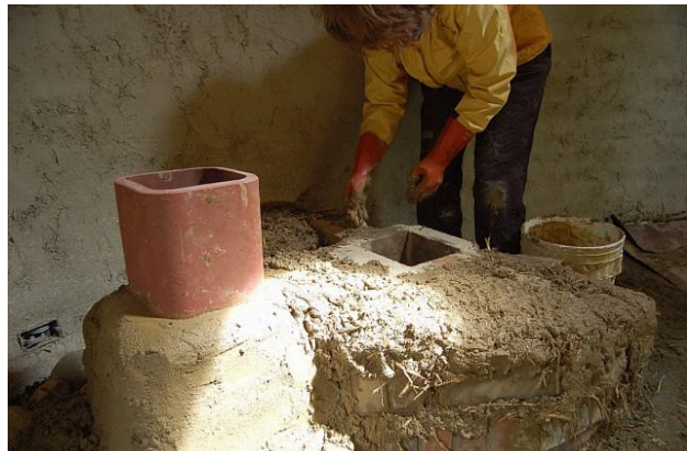
Figura 55 - Execução da parede 70
