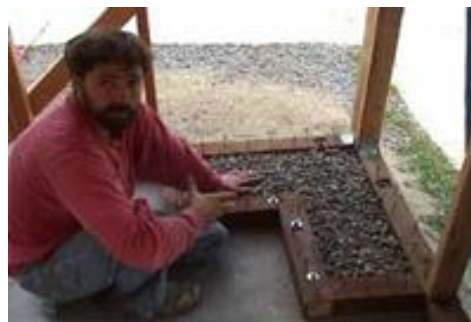
Figura 61 Bases de madeira e brita fixas às fundações de betão 75
