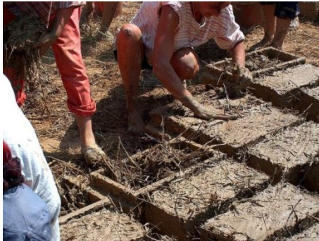
Figura 34 - Fabrico de tijolos de adobe 52
