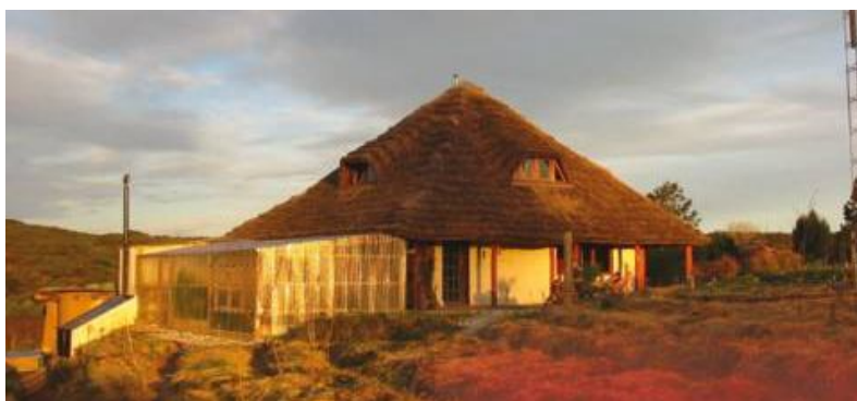
Figura 58 Construção antiga, em fardos de palha, que dura até aos nossos dias 73
