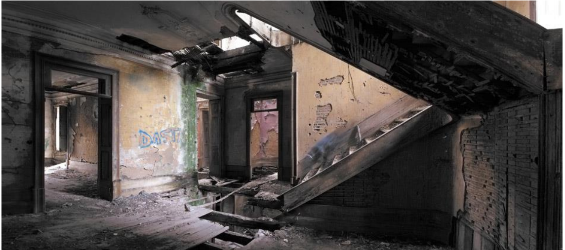
Figura 17. Fotografia das Escadas Principais do Palacete.
