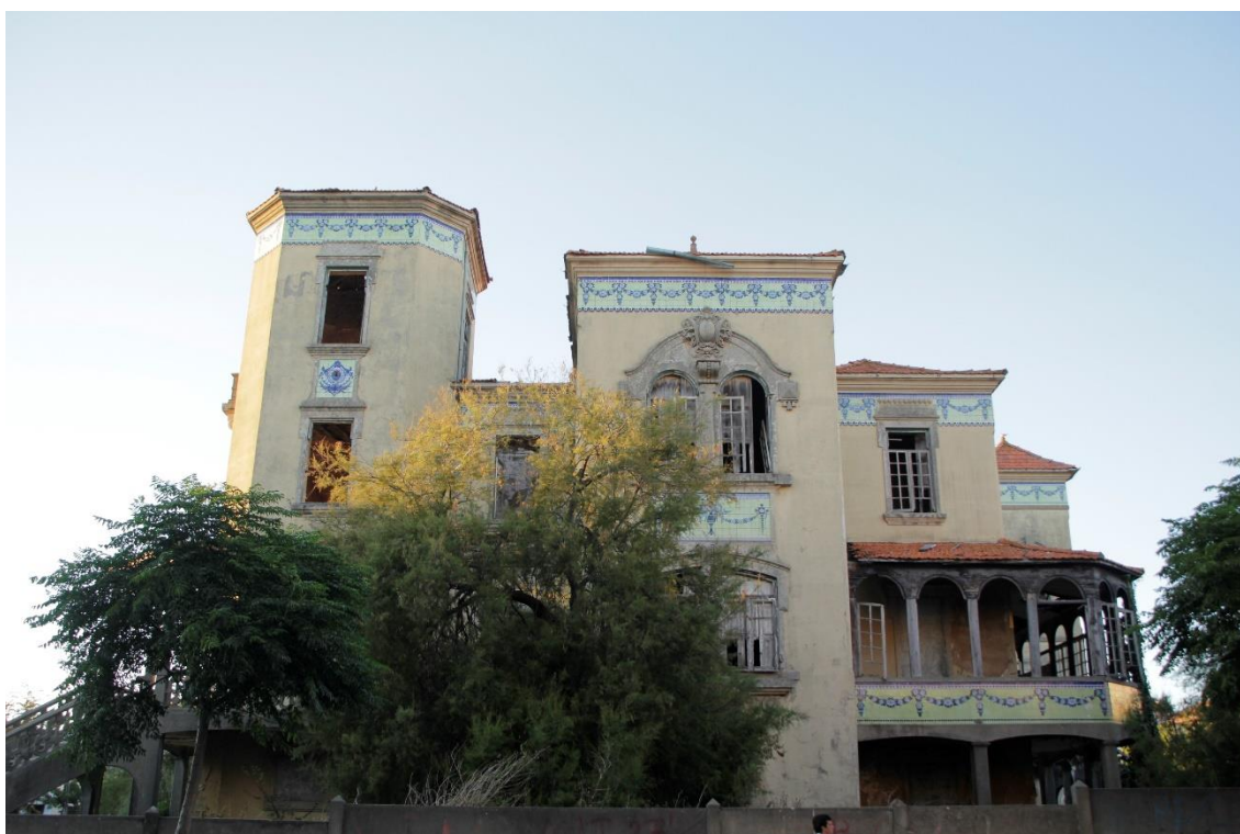
Figura 10. Fotografia da Fachada Sul.
