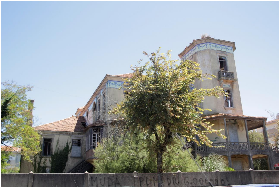
Figura 14. Fotografia da Fachada Este.
