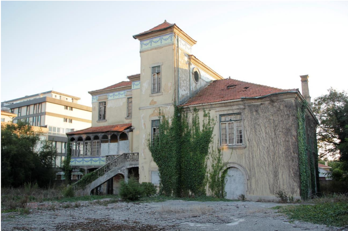
Figura 11. Fotografia da Fachada Oeste.
