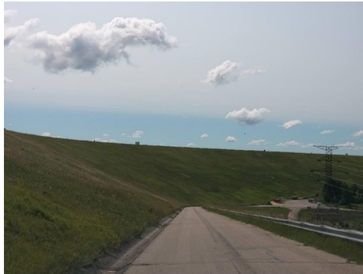
Figura 2.3 - Reservatório de bombagem com revestimento a relva
