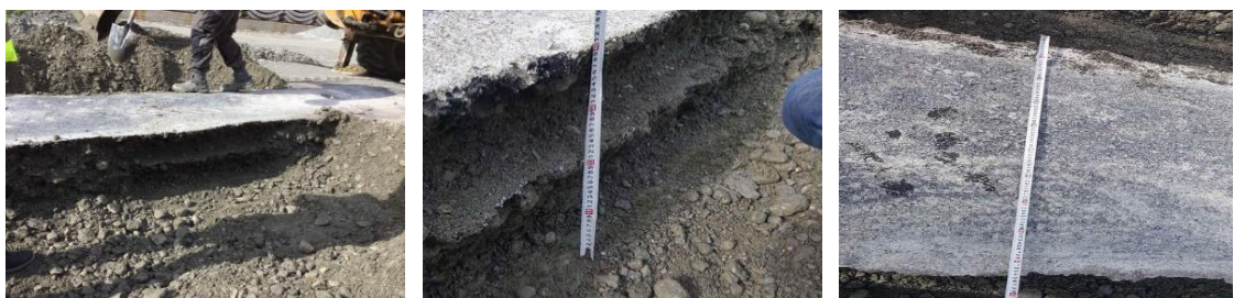
Figura 4.11 - Controlo da espessura e forma das camadas
