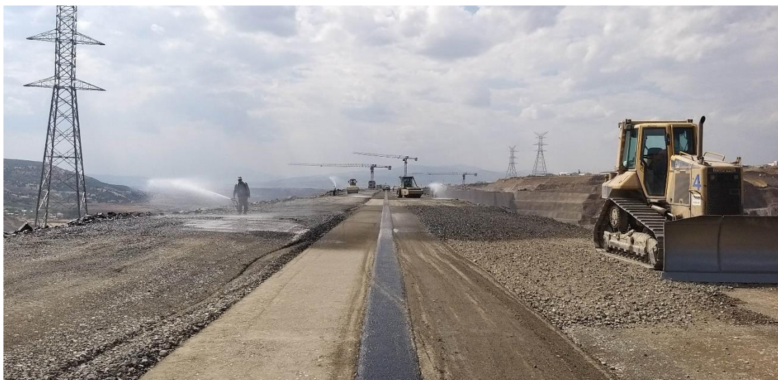
Figura 2.2 - Terraplenagem após a colocação do núcleo asfáltico (Barragem de Kaleköy, Turquia 2019)
