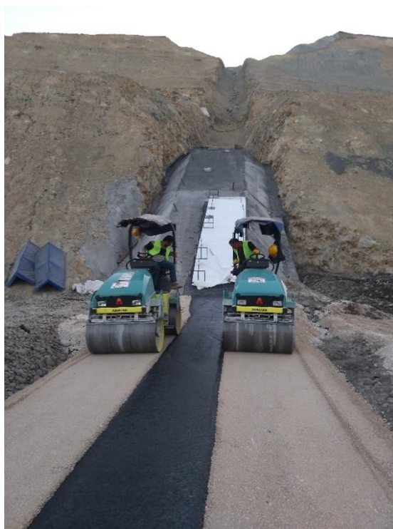
Figura 3.7 - Compactação da zona de filtro (Barragem de Alpaslan II, Muş, Turquia 2019)
