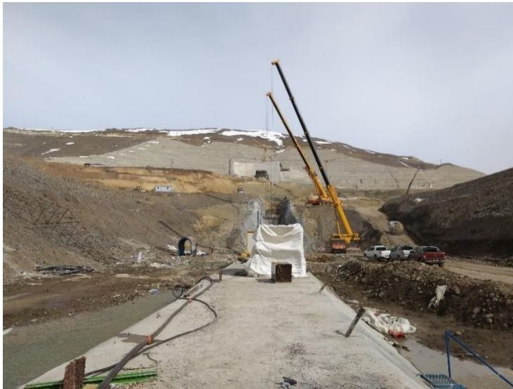
Figura 2.8 - Construção do plinto de betão (Barragem de Alpaslan II, Muş, Turquia 2019)
