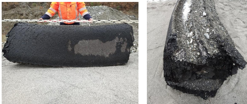
Figura 3.4 - Exemplo da flexibilidade de um núcleo asfáltico (Barragem de Mogliçë, Albânia 2019)
