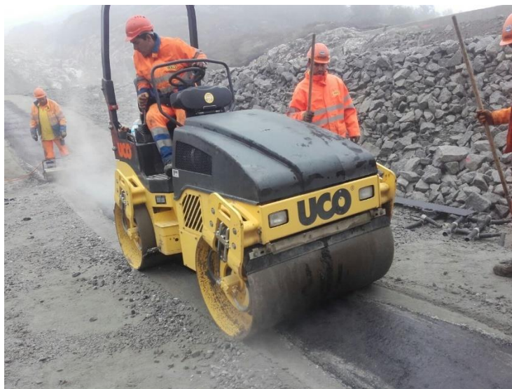
Figura 3.6 - Compactação final do núcleo asfáltico (Barragem Skjerkevattn, Noruega 2016)
