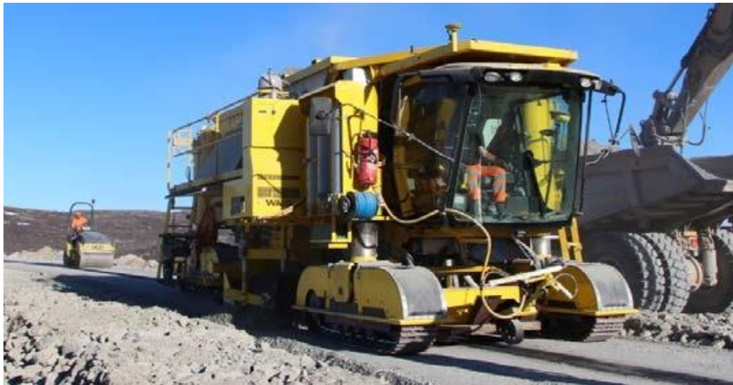
Figura 3.5 - Recente máquina de pavimentação do núcleo asfáltico da WALO (Barragem Skjerkevatn, Noruega 2016)
