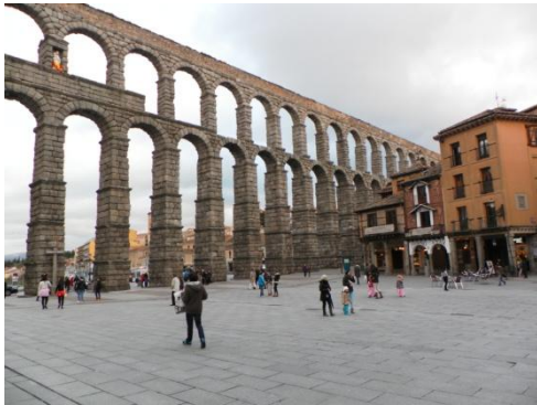
Fig. 35: Aqueduto romano em Segóvia
