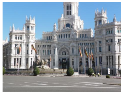
Fig. 40: Antigo Edifício dos Correios em Madrid
