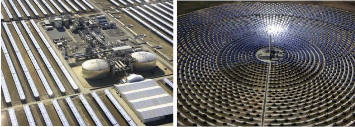
Figura 2.31: Centrais térmicas com recursos à tecnologia de concentração da radiação solar. Central de calha parabólica e torre solar respetivamente (adaptado de [69]).
