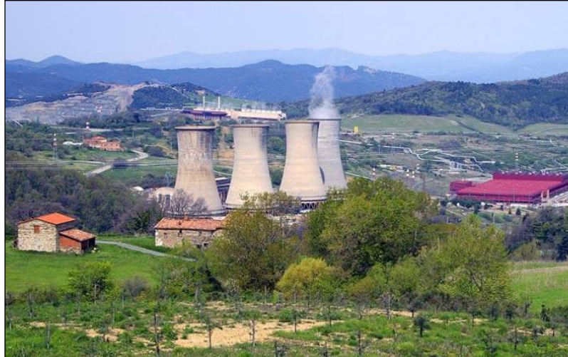
Figura 2.1 - Vista geral das torres de arrefecimento de uma central geotérmica em Larderello, Itália (Rio, 2011).
