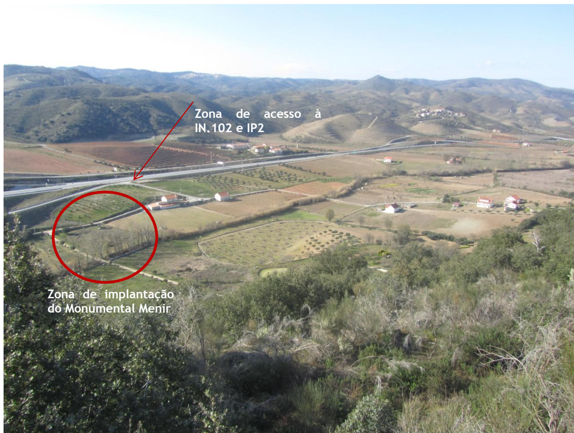
Figura 80_Vista do local onde será implantado o Monumental Menir (autor, 2015).
