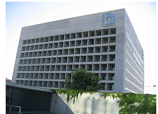
Figura 120 Fachada da Caixa Geral de Granada orientada a Sul
