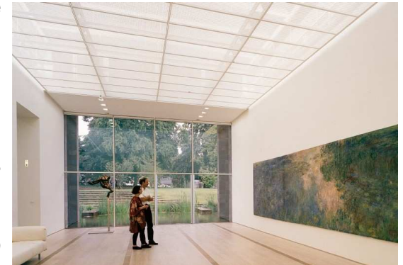
Figura 149 Iluminação natural indirecta dentro das galerias bloqueia a luz solar directa, Nascher Sculpture, Dallas-EUA, Renzo Piano
