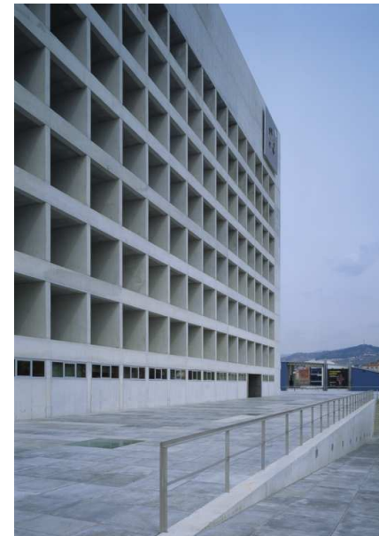
Figura 124 Brise soleil na fachada sul da Caixa Geral de Granada, Campo Baeza, 2001
