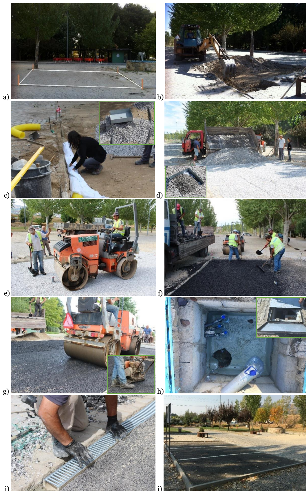
Figura 5.10 Fases da construção do TE2: a) Marcação do terreno; b) Escavação do terreno; c) Colocação do tubo de drenagem e dos tubos de ligação às caixas de recolha; d) Colocação das britas e das caixas de recolha; e) Compactação das camadas de sub-base e base com cilindro de rolos; f) Aplicação das camadas MG e MF produzidas em central; g) Compactação das camadas MG e MF com cilindro de rolos e placa vibratória; h) Caixa de recolha geral; i) Colocação de canal com grelha para recolha das águas superficiais; j) Vista geral do troço com colocação de lancis e marcação dos estacionamento
