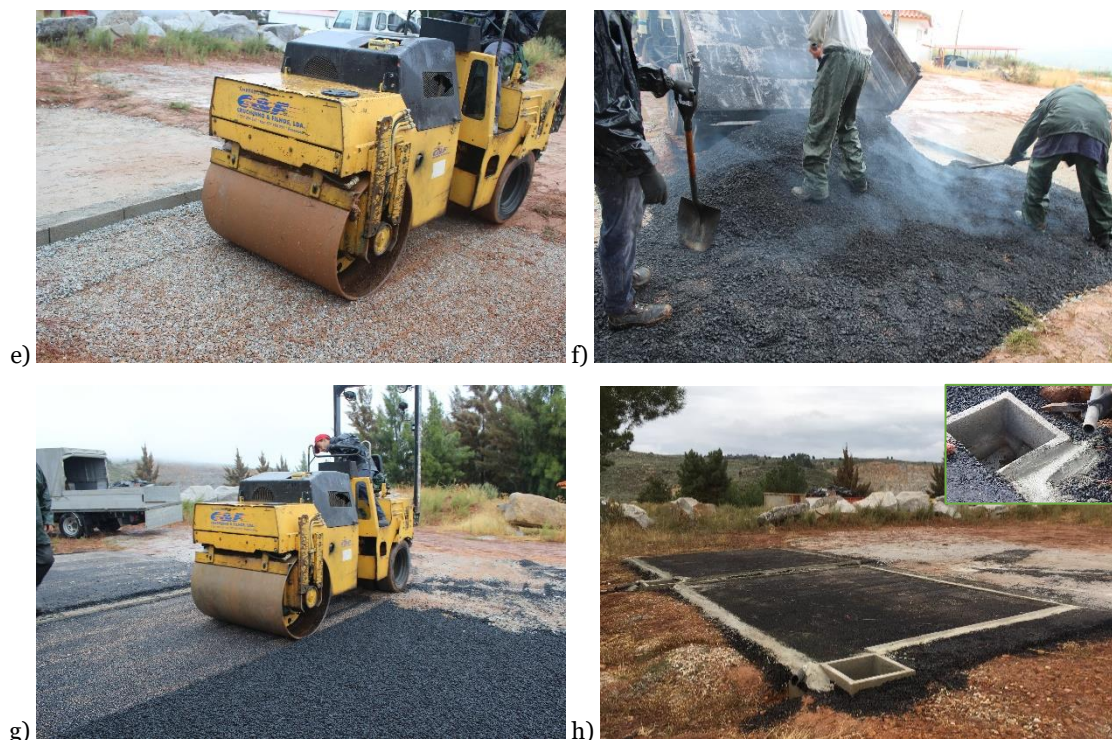
Figura 5.9 (continuação) Fases da construção do TE1: e) Compactação das camadas de sub-base e base com cilindro de rolos; f) Aplicação das misturas betuminosas; g) Compactação das camadas betuminosas com cilindro de rolos; h) Construção de valetas e vista geral do troço final
