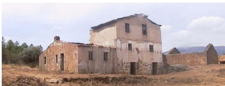
Figura 135 - Vista Sudeste do edifício 255362QtSeves_ED04
