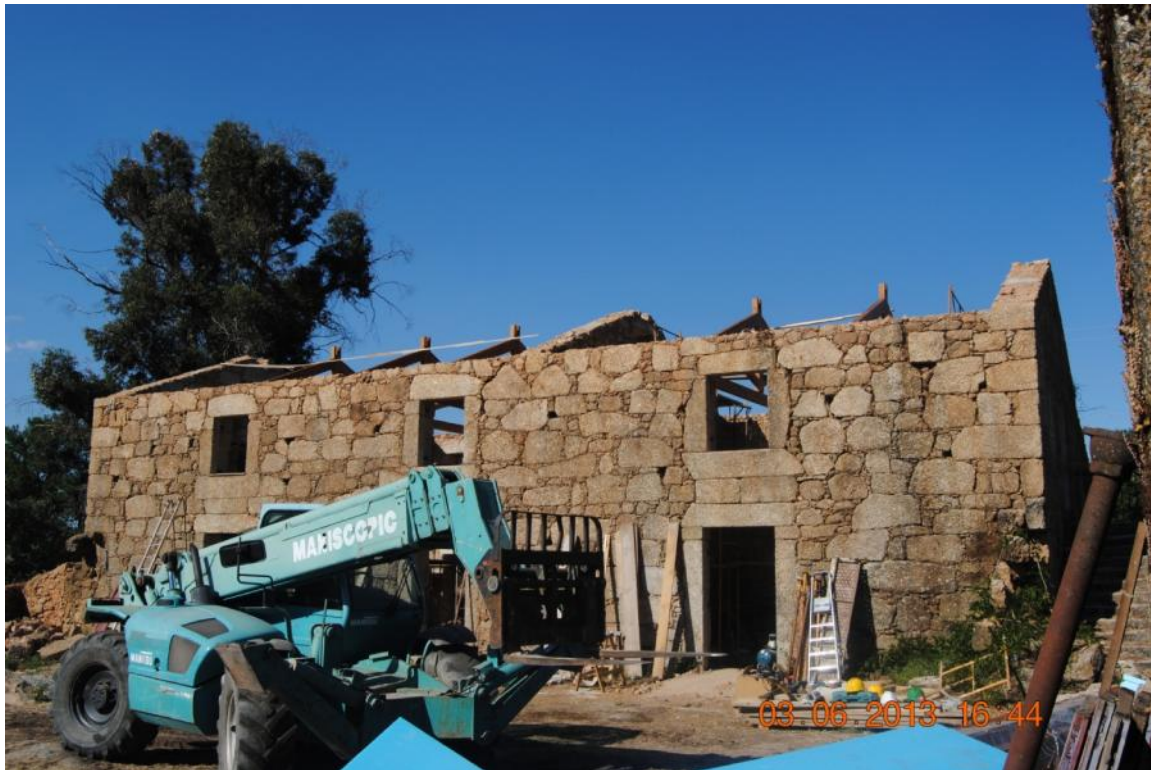
Figura 168 - Aspecto do posicionamento das asnas
