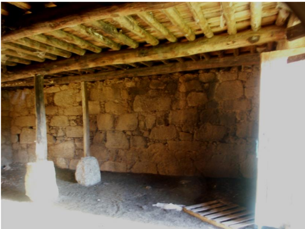
Figura 162 - Vista do interior da loja no Rés-do-chão do edifício 255362QtSeves_ED01
