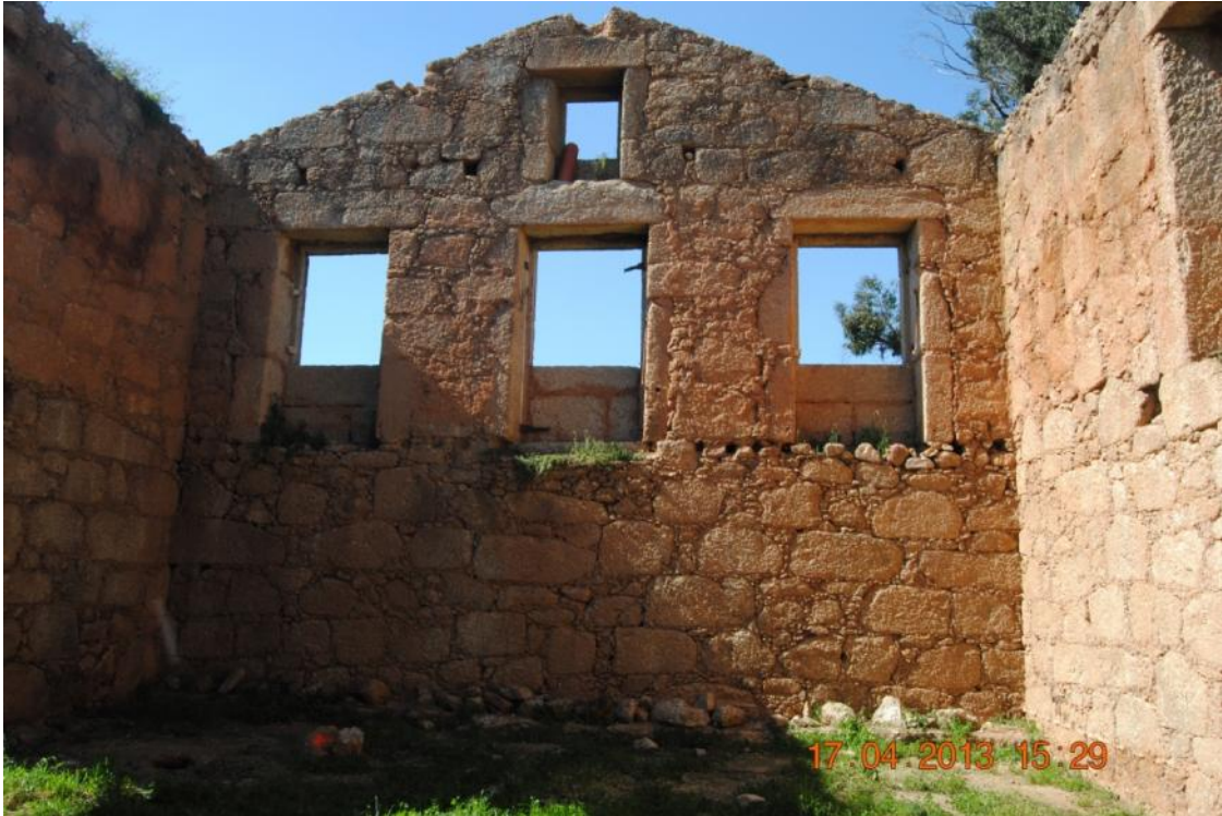
Figura 114 - Interior do edifício residencial principal, parede norte, em Abril de 2013
