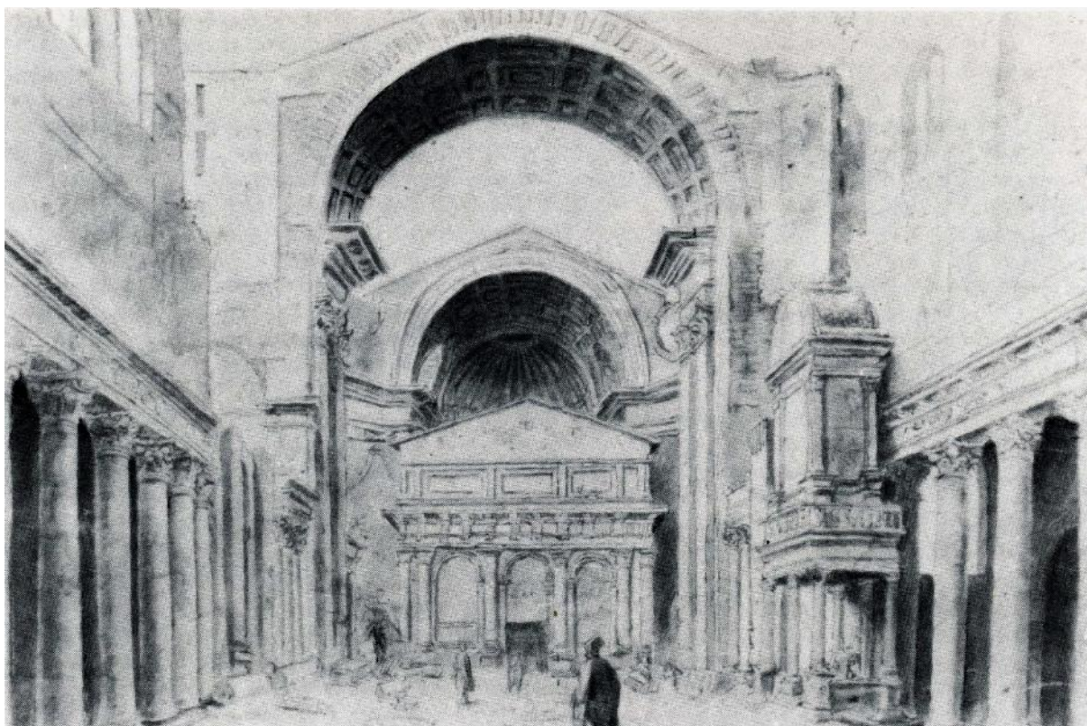
Figura 5 - Desenho por Marten Van Heemskerck com a antiga basílica sob arcos do templo novo em construção. São ainda visíveis as colunatas pré-existentes. (Blog Counterlight's peculiar)
