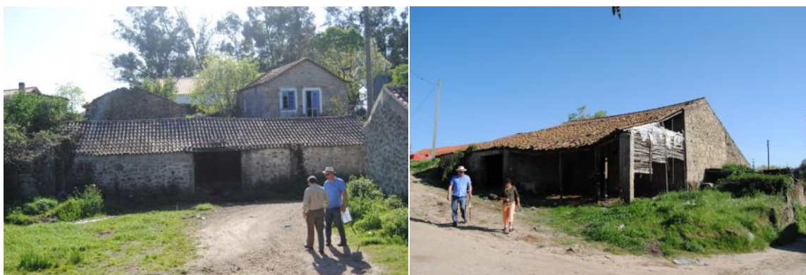
Figura 82 - Edifício dentro do qual existe uma mina de água
