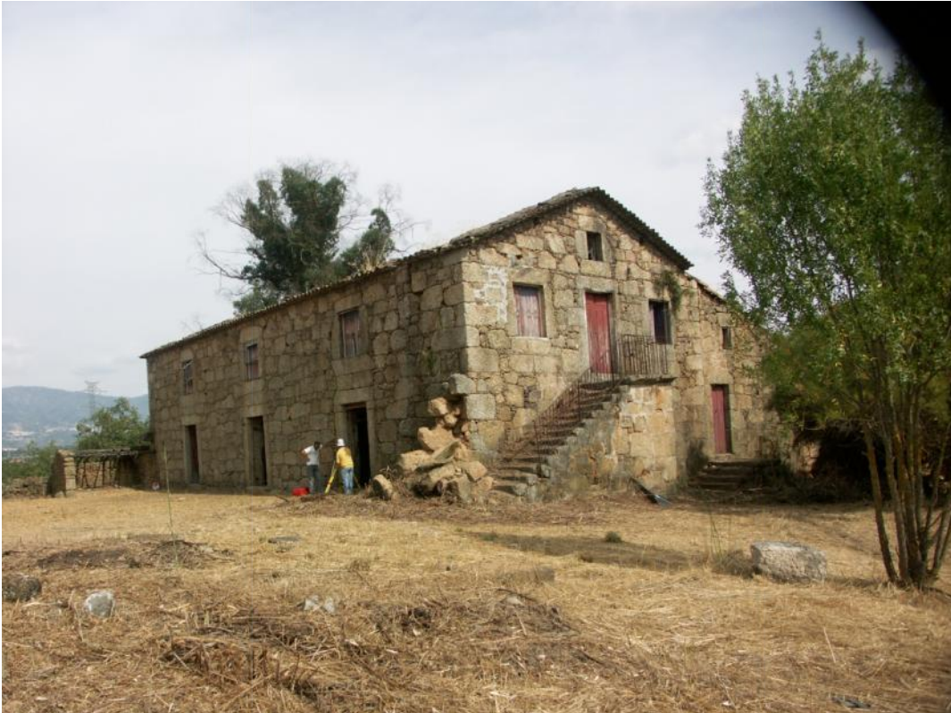
Figura 161 - Vista das fachadas Norte e Poente do edifício 255362QtSeves_ED01
