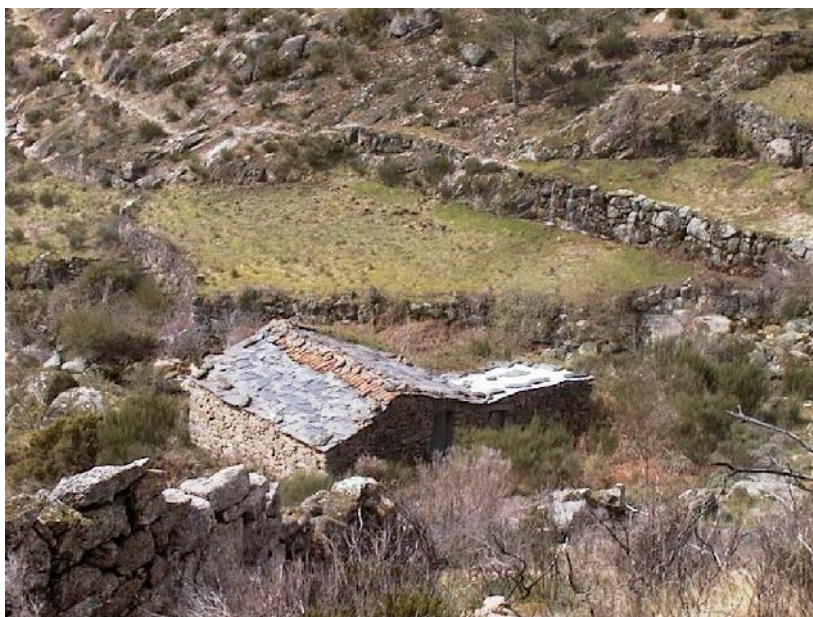
Figura 97 - Cobertura sobrevivente em transformação
