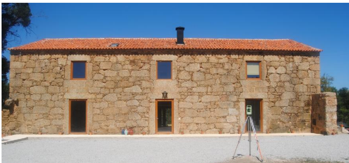
Figura 167 - Fachada principal do edifício residencial principal, após a execução das obras.
