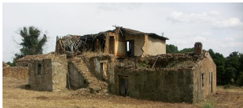
Figura 136 - Vista Sudoeste do edifício 255362QtSeves_ED04
