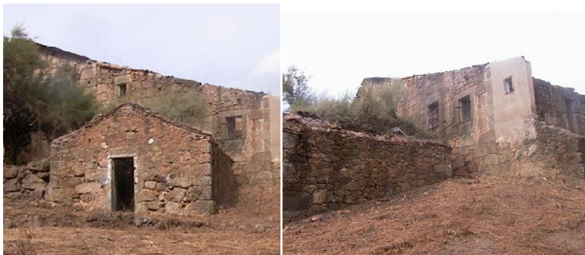
Figura 131 - Vista sul do edifício
