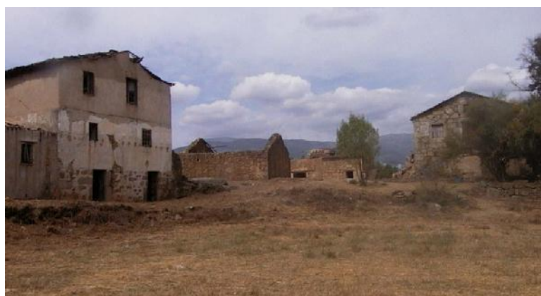
Figura 137 - Vista parcial do conjunto com 255362QtSeves_ED04 em primeiro plano
