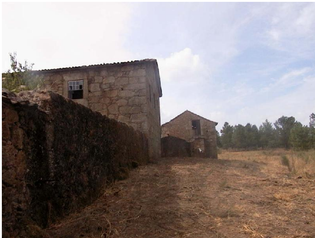
Figura 110 - Vista do alinhamento dos edifícios ED01 e ED02
