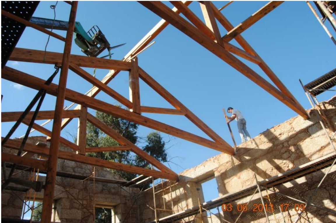
Figura 169 - Apoio do pessoal ao assentamento das asnas e madres
