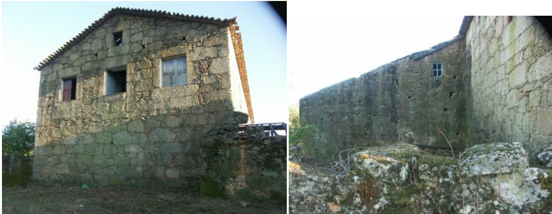
Figura 158 - Vista da fachada Norte do edifício 255362QtSeves_ED01
