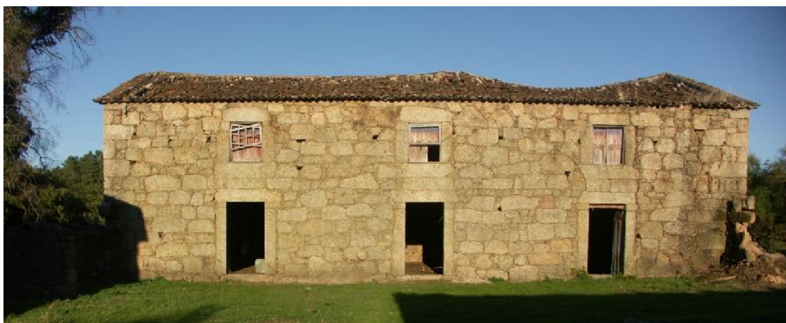
Figura 165 - Fachada principal do edifício residencial principal, antes da obra.
