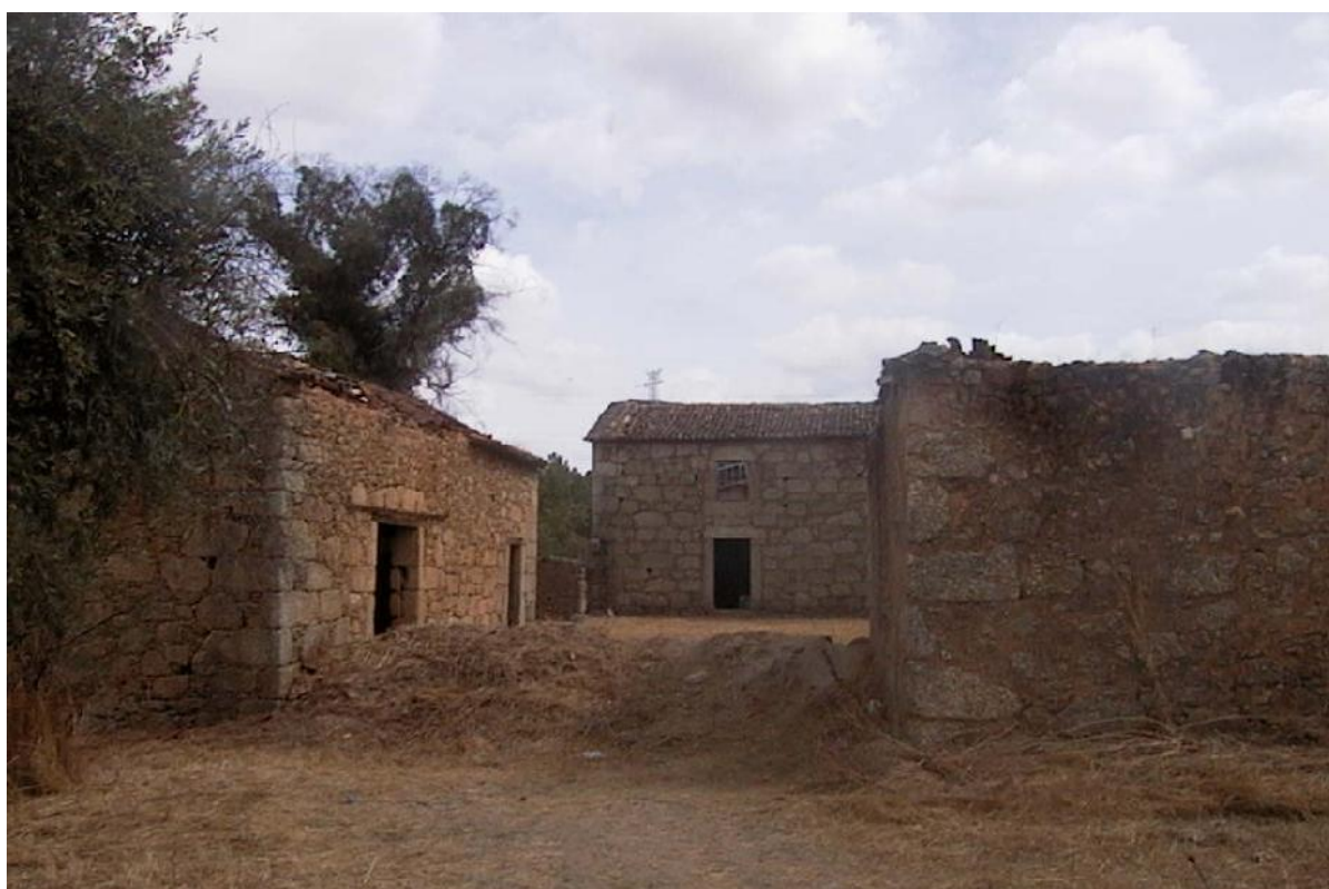
Figura 150 - Vista para o interior do espaço interno do conjunto com o edifício 255362QtSeves_ED02 à esquerda
