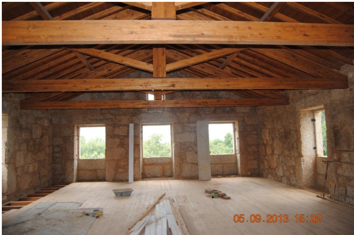
Figura 176 - Aspecto do interior do interior do edifício no decorrer da obra
