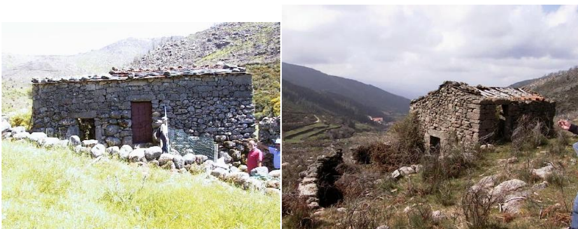
Figura 95 - Edifício sobrelevado com diferente aparelho
