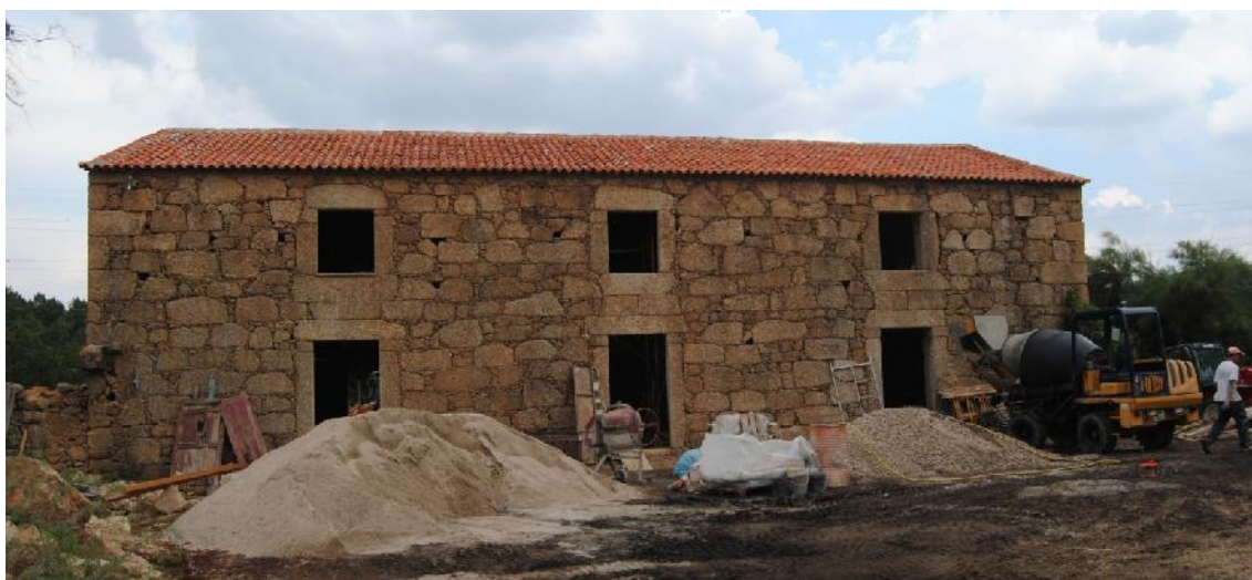
Figura 166 - Fachada principal do edifício residencial principal, durante a obra.
