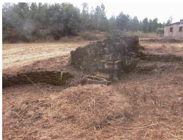
Figura 109 - Parte do sistema de aproveitamento de água: fonte e tanque.
