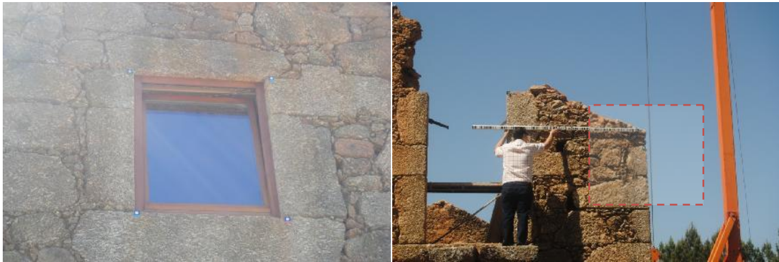
Figura 126 - Aspecto dos alvos colados na parede a levantar
