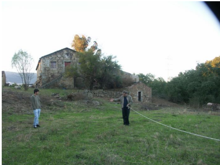
Figura 160 - Vista da fachada Sul do edifício 255362QtSeves_ED01
