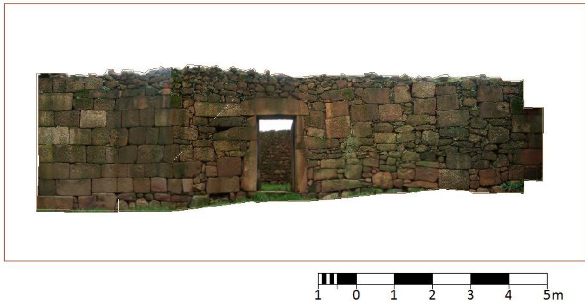
Figura 58 - Fotomosaico a partir do qual se realizou o alçado base da capela da tapada de São Pedro, Capinha, Fundão
