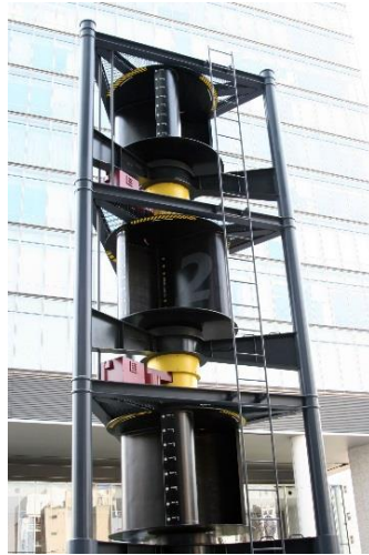
Figura 2.3 - Turbina eólica Savonius.
