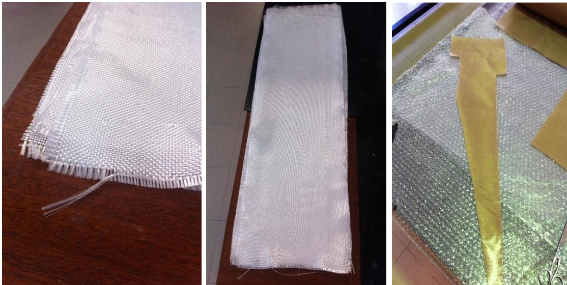
Figura 3.42 - Corte das tiras de fibra de vidro e de tecido desmoldante.
