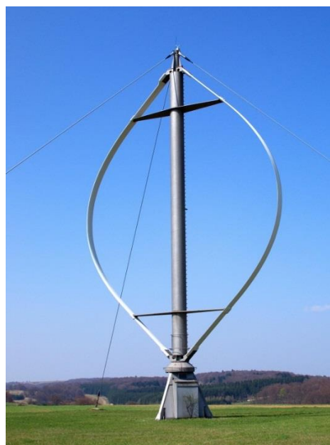
Figura 2.2 - Turbina eólica Darrieus.
