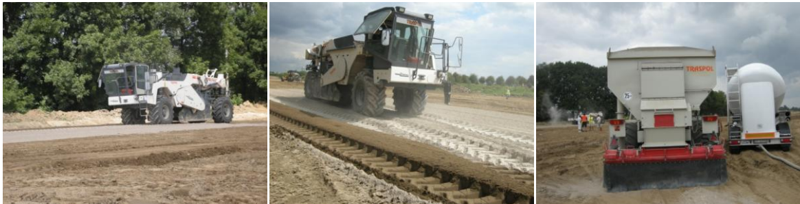
Fig. 5.11 - Execução com uma recicladora da mistura do solo com ligante hidráulico in situ
