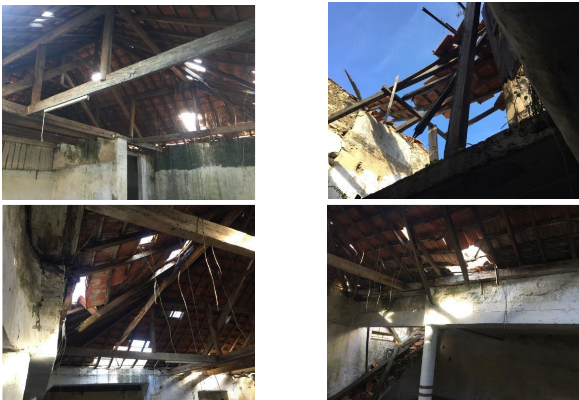
Figura 26, 27, 28 e 29- Estado atual da Casa de Sequeira Monterroso | O.A.Z
