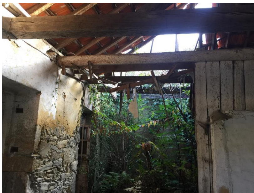
Figura 45- Parede de pedra e alvenaria e Estrutura de madeira | Casa de Sequeira Monterroso | O.A.Z
