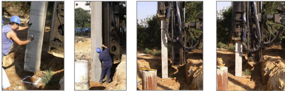
a) b) c) d) Figura 4.1 - Imagens da execução da estaca de betão armado pré-fabricadas cravada dinamicamente: a) implantação da estaca; b) verificação da verticalidade da estaca; c) d) cravação da estaca (Costa Esteves, 2005).
