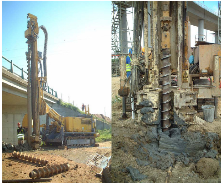
Figura.2.12- Perfuração a trado para instalar uma micro-estaca (Miranda e Martins, 2006).
