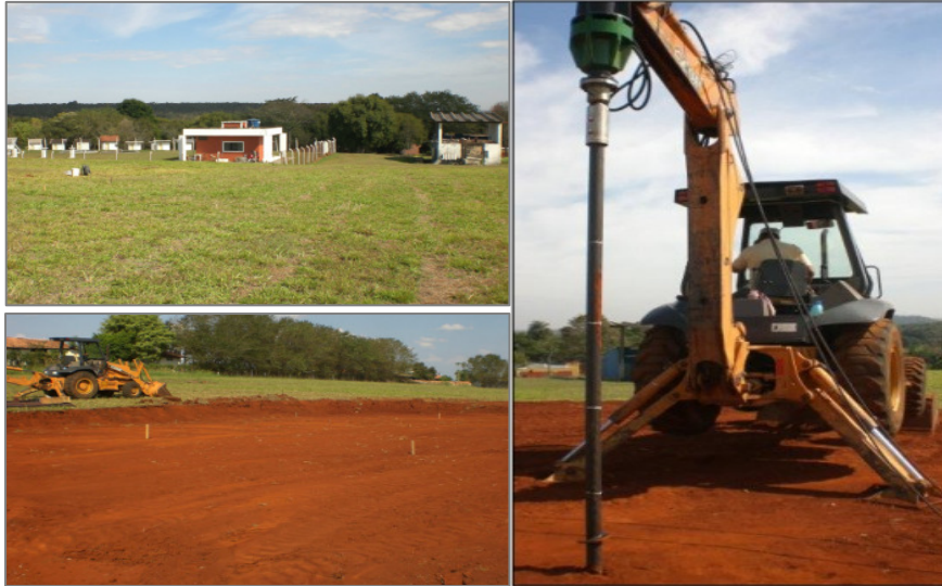
Figura 4.26 - Instalação de uma estaca helicoidal no campo de Estudos Experimental do Centro de Recursos Hídricos e Ecologia Aplicada da Escola de Engenharia de São Carlos - Brasil (a partir de Louro Carlos, 2013).
