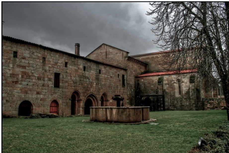
Figura 2-13 - Vista da sala do capítulo do Convento de Santa Maria de Aguiar
