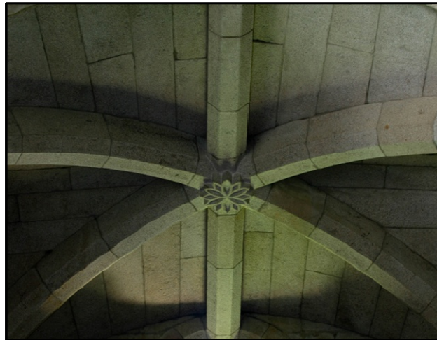
Figura 2-9 - Pormenor do fecho da abóbada
