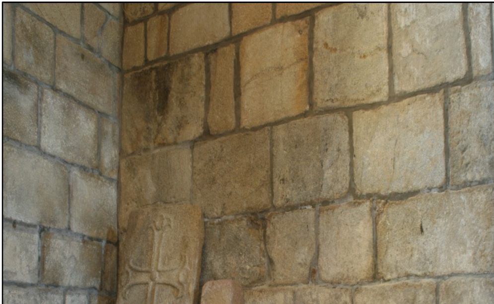
Figura 3-1 - Alvenaria Estrutural do Convento
