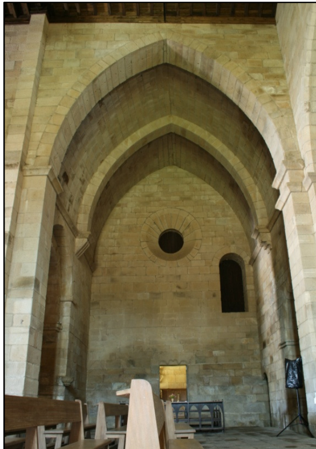
Figura 3-5 - Arco da nave lateral
