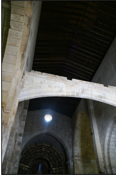
Figura 2-6 - Vista interior da nave central e transepto (2)
