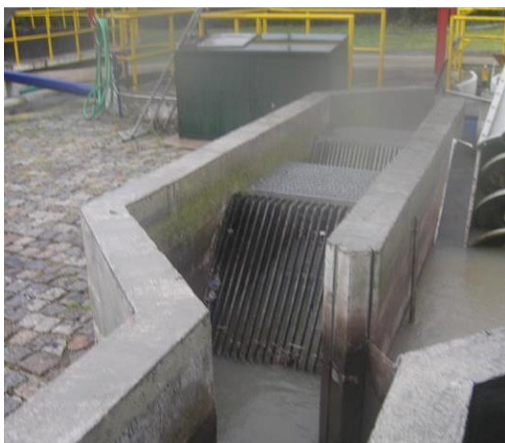
Figura 2.3: Representação em planta e pormenores de uma obra-de-entrada, com sistema de grades instalado em canal (DGA, 1989), e fotos de grades gravíticas e mecanizada
