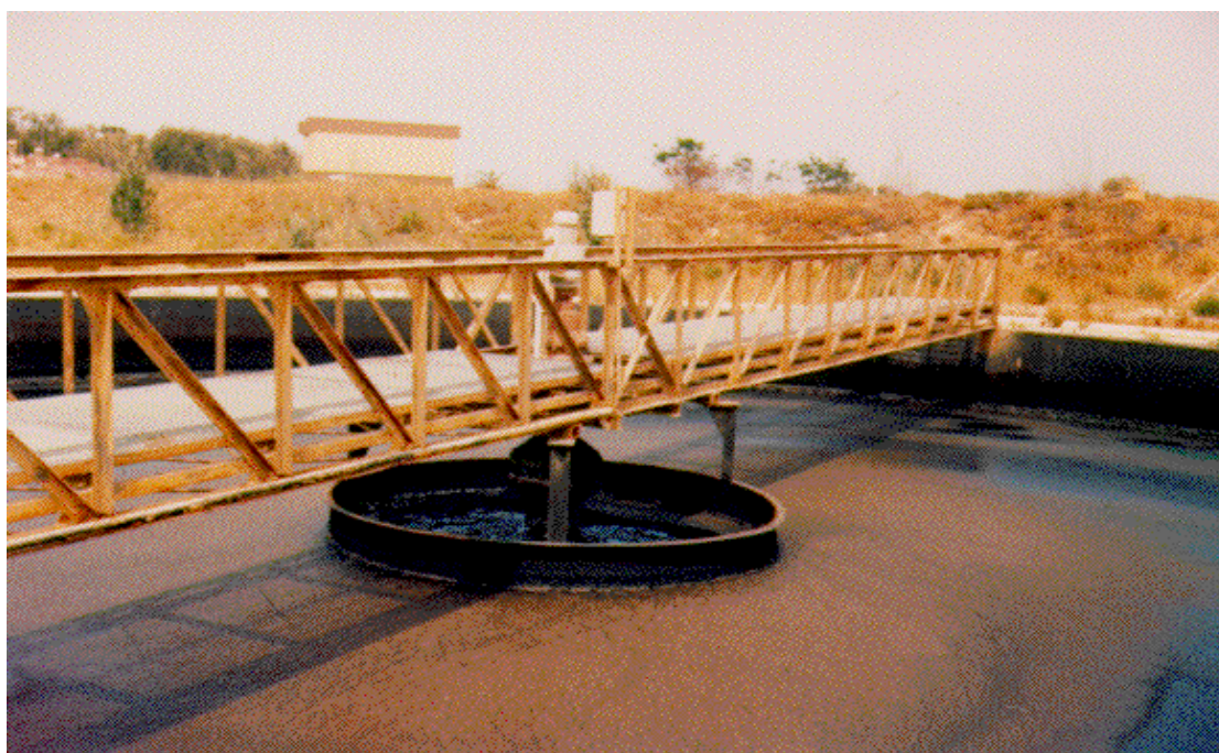
Figura 2.13: Espessador para lamas
