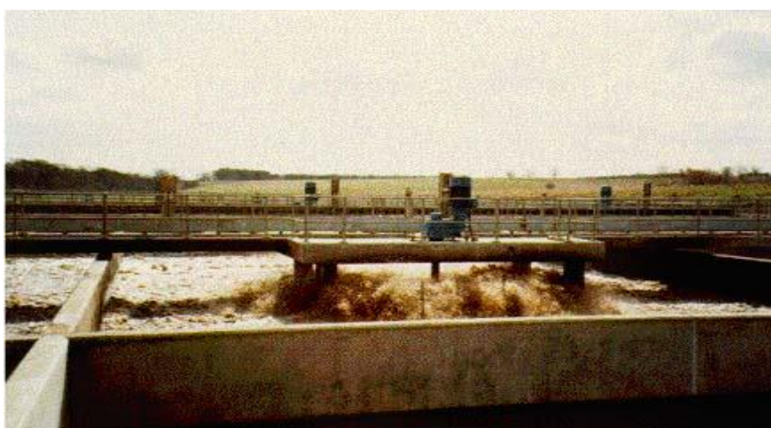
Figura 2.7: Representação esquemática de um sistema convencional de média carga (Albuquerque, 2008)
