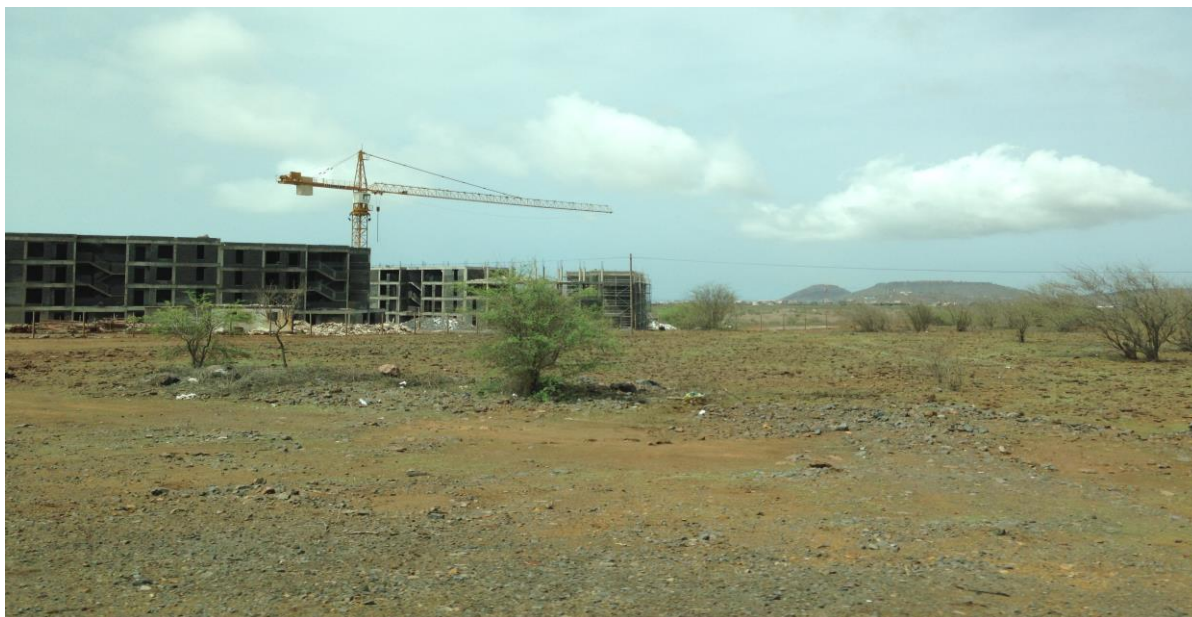
Figura 1.3: Construções dos primeiros edifícios em agosto de 2015
