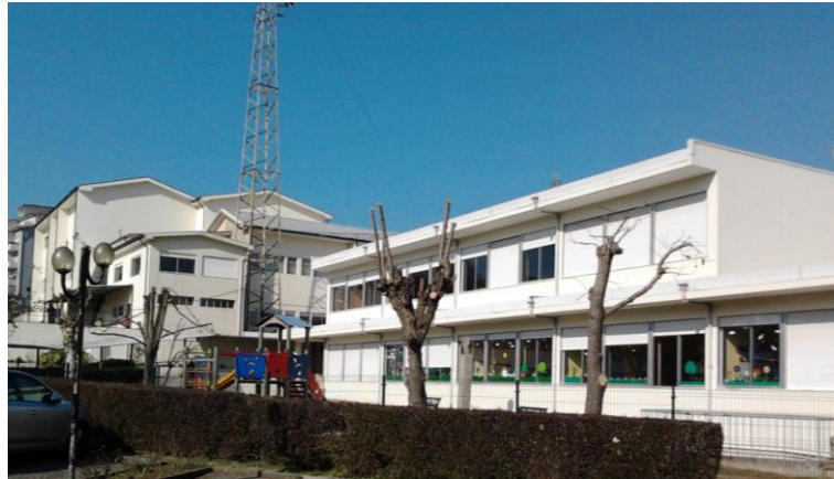
Imagem 30 | Foto - Instalações do CAOD 28.12.11
