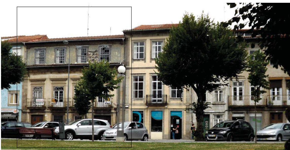
FIG. 48 – EDIFÍCIO LOCALIZADO NA AVENIDA CENTRAL
