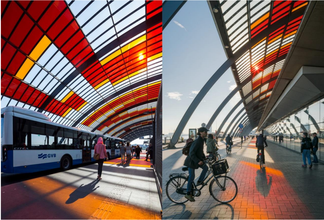
Figura 25 – Nova cobertura da Estação Central de Amsterdão, 2019
