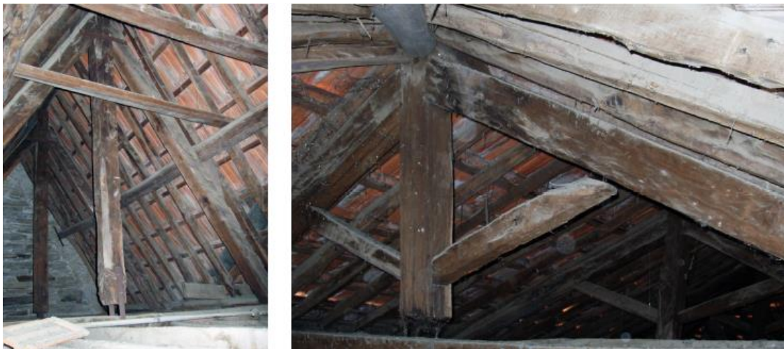
Figura 46 – Fotografia do tipo de Cobertura do edifício
