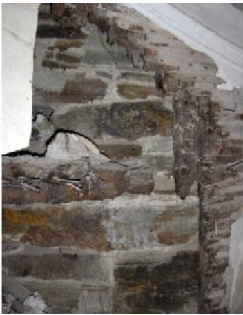
Figura 42 – Parede resistente e de elementos em cantaria no exterior
