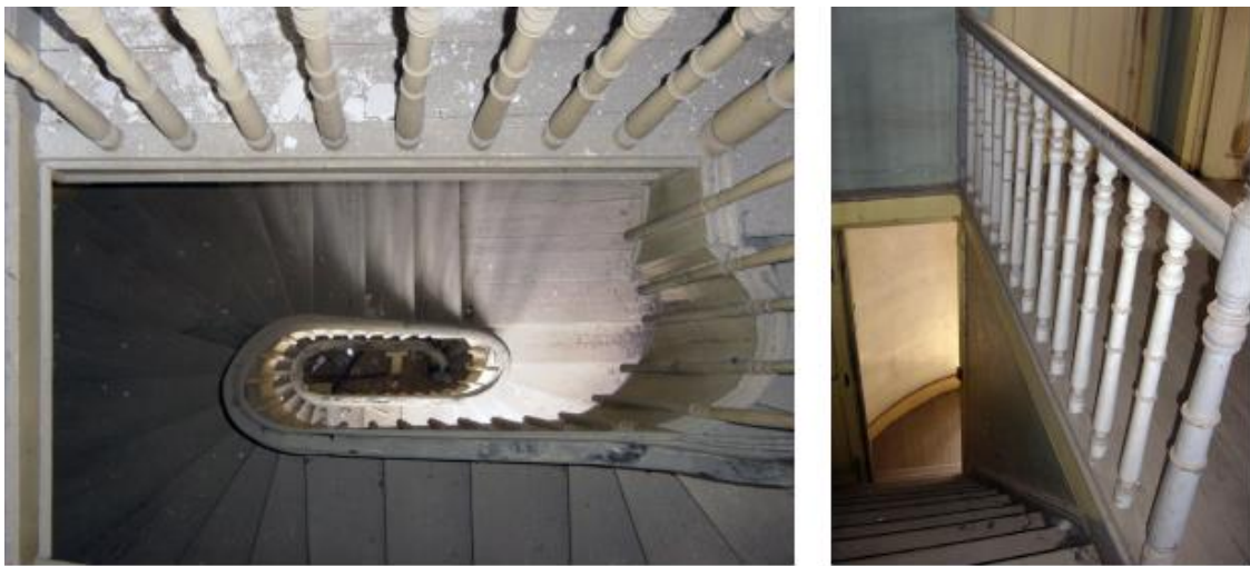
Figura 45 – Fotografia da escadaria principal do edifício
