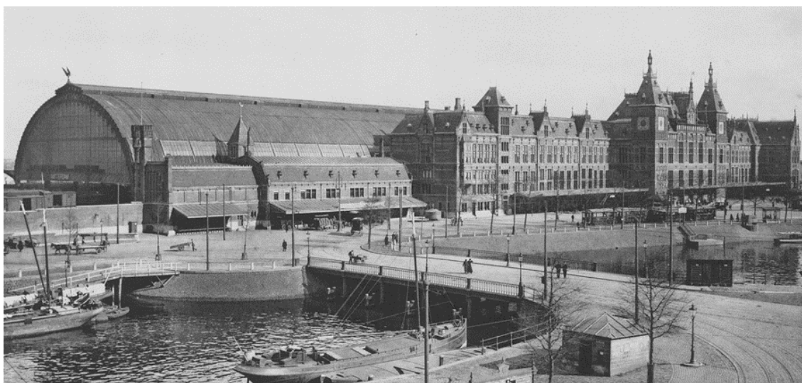
Figura 23 – Estação Central de Amsterdão com a sua primeira cobertura, sem data
