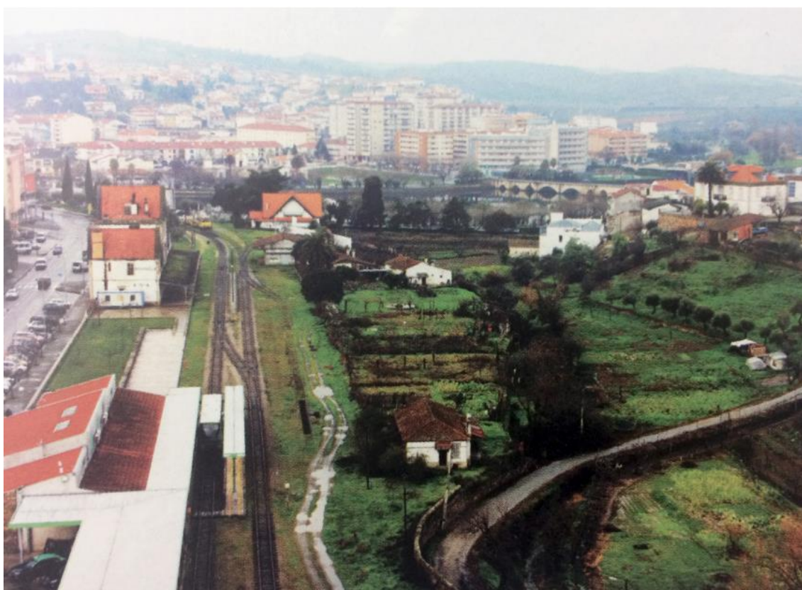
Figura 31 - Vista aérea sobre a área de intervenção
