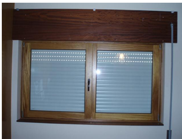
Figura 15 – Exemplo de caixilharia em madeira depois da reabilitação
