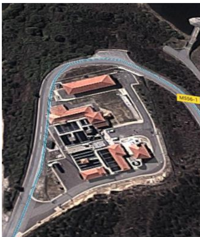
Figura 4.1 - Vista aérea da ETA do Caldeirão
