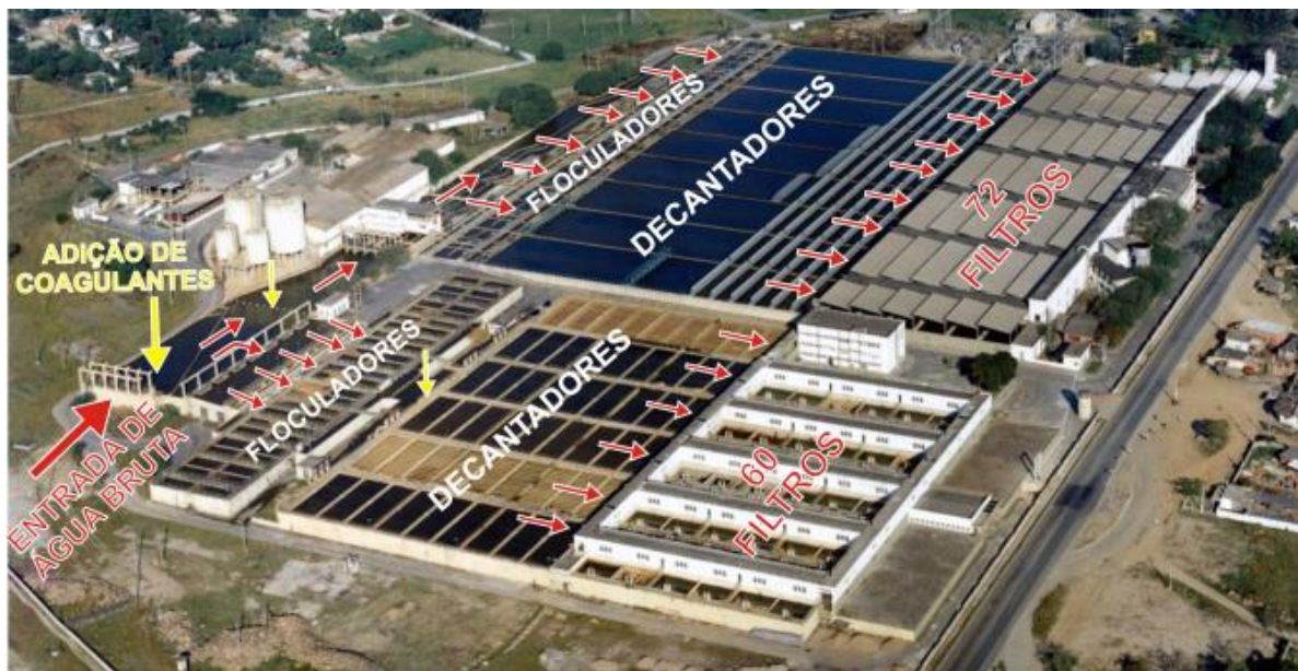
Figura 2.1 - Fotografia aérea da ETA de Guandu
