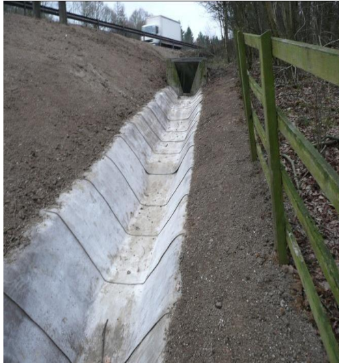
Figura 3.1 - Valeta para recolha de águas pluviais
