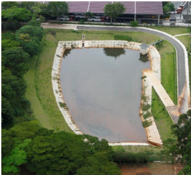
Figura 3.6 - Bacia de retenção para AEE
