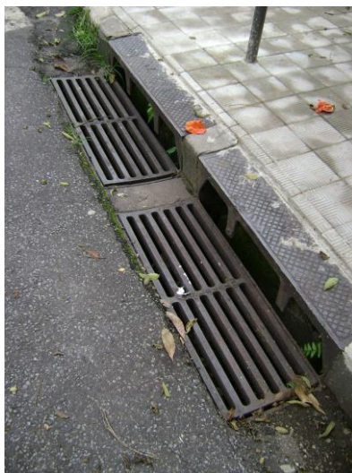
Figura 3.2 - Sarjeta para recolha de águas pluviais e respectivo esquema em corte
