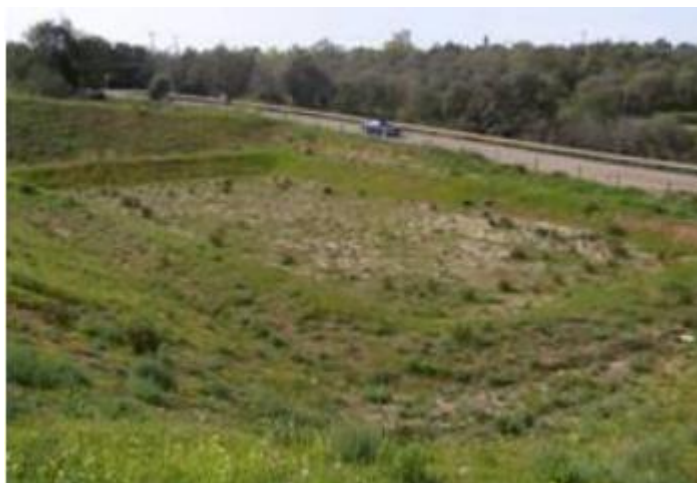
Figura 3.7 - Bacia de infiltração para AEE
