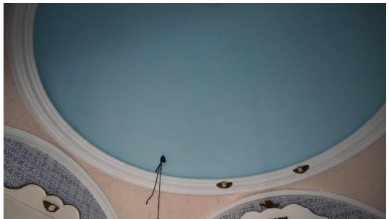
Figura 56 - Vista interior da capela - cúpula, 2019
