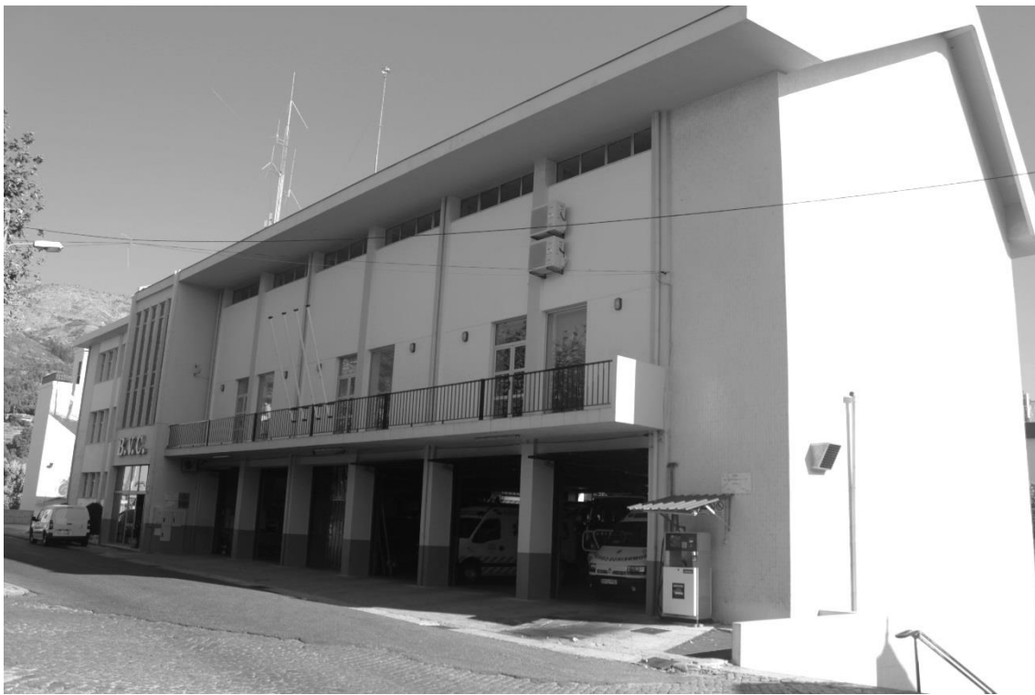
FIG. 002 - Fachada Sudoeste com entrada principal do quartel do CBV da Covilhã
