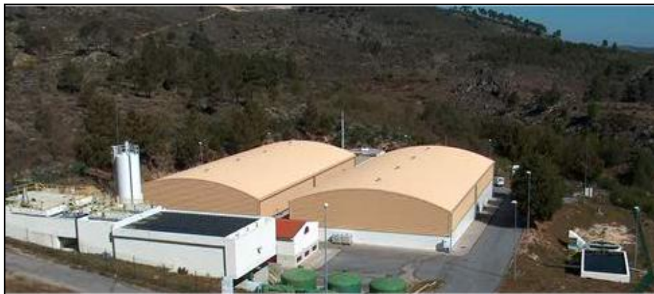
Figura 4.6 - ETA do Concelho de Mêda (Ranhados).
