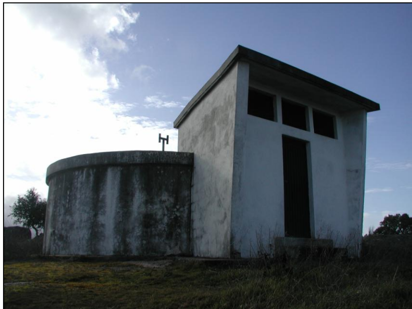
Figura 4.7 - Exemplo de reservatório de água para Abastecimento Público do Concelho de Mêda na Freguesia da Prova.
