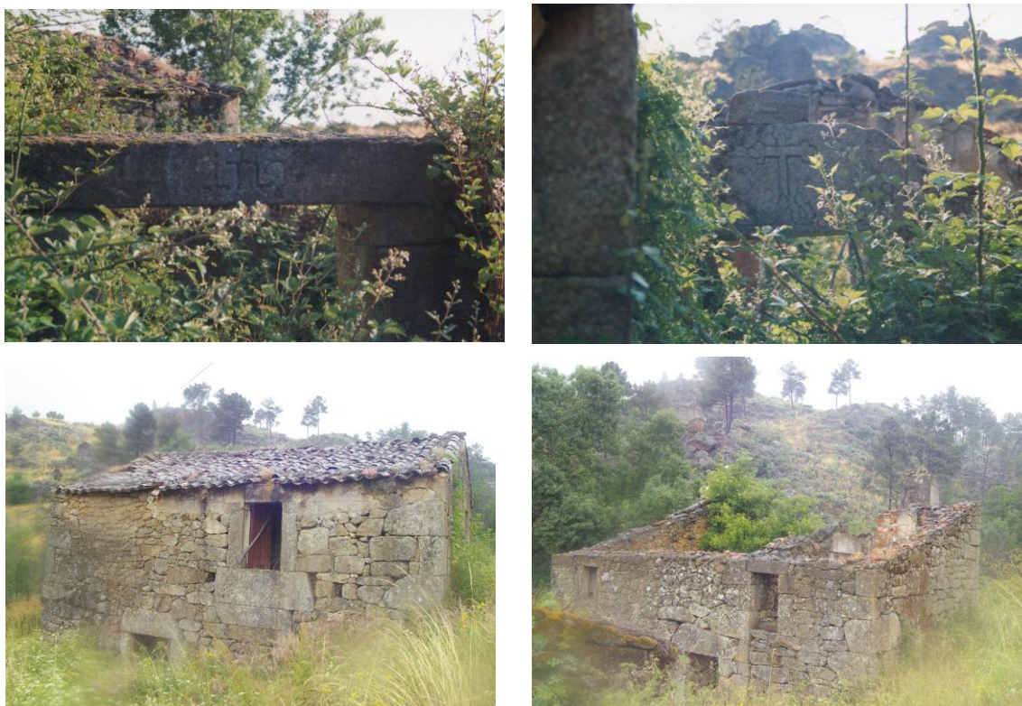
Figura 6.18 - Imagens de aspectos do antigo casario, na margem direita da ribeira Teja, que apoiava as Termas da Areola.
