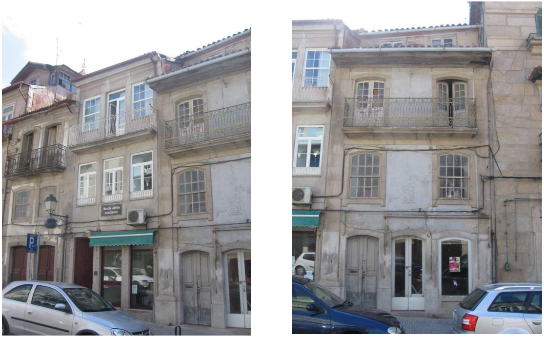
Ilustração 64 - Exemplo de edifícios a reabilitar
