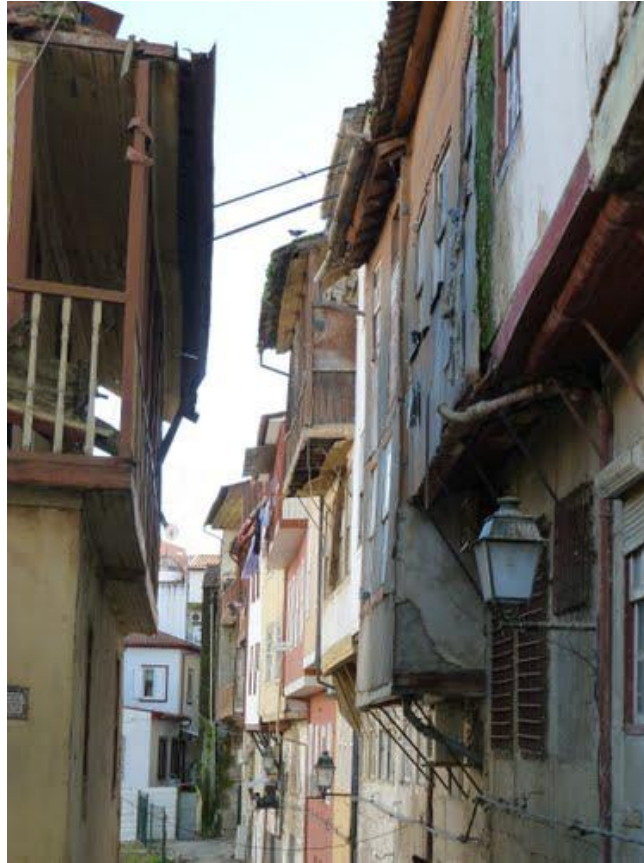
Ilustração 4 - Edifícios deteriorados, Chaves, 2012
