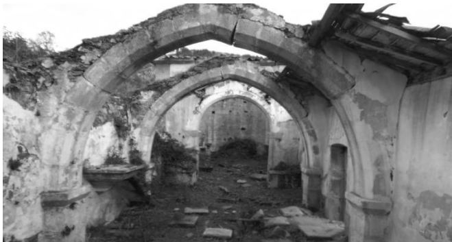
Fig. 10 - Interior da Igreja de São Miguel, 2013.
