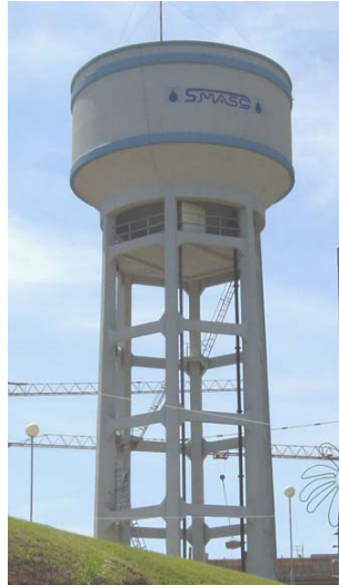
Fig. 1.13 - Reservatório elevado circular de abastecimento de água [13]
