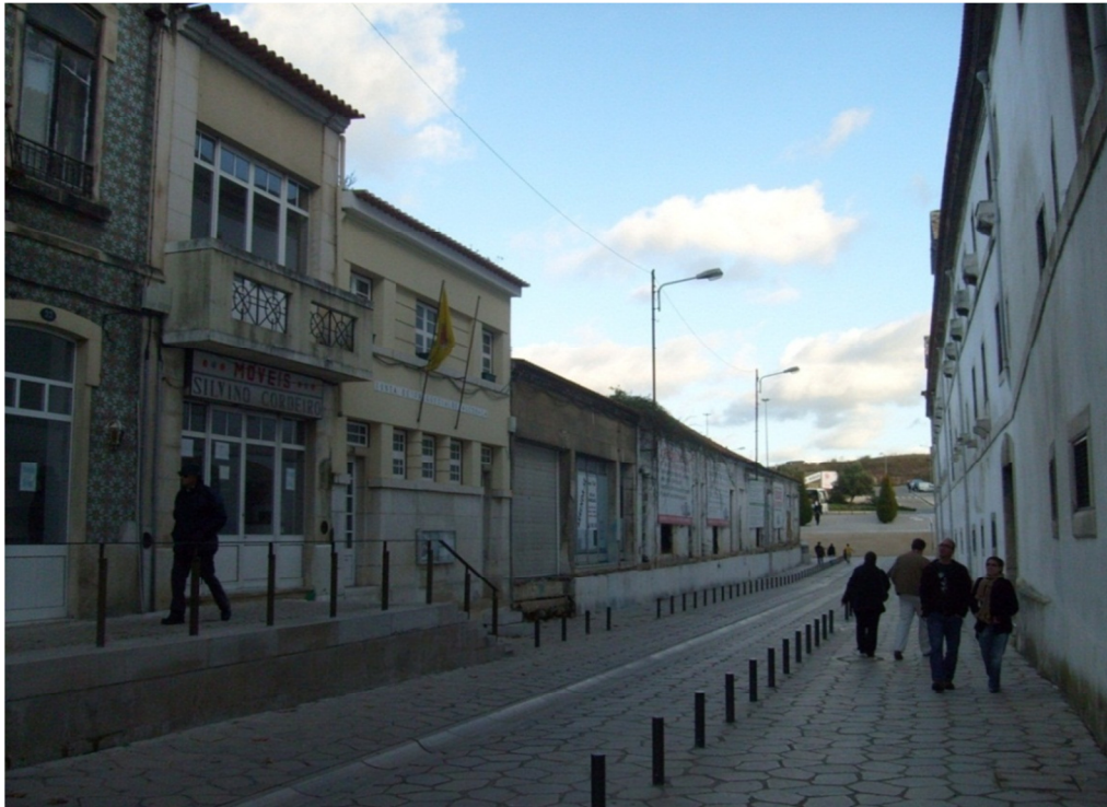
Fig.12 Vista Geral da fachada pré-existente a Sul
