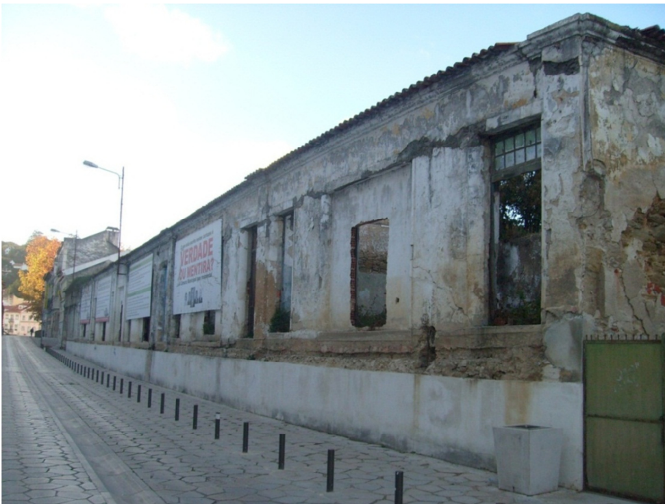
Fig.9 Vista sobre fachada Sul do edifício pré-existente, no sentido Nascente-Poente
