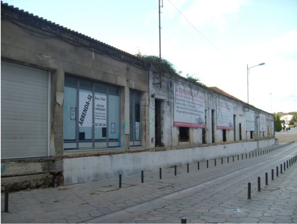
Fig.10 Vista sobre a fachada Sul do edifício pré- existente no sentido Poente-Nascente
