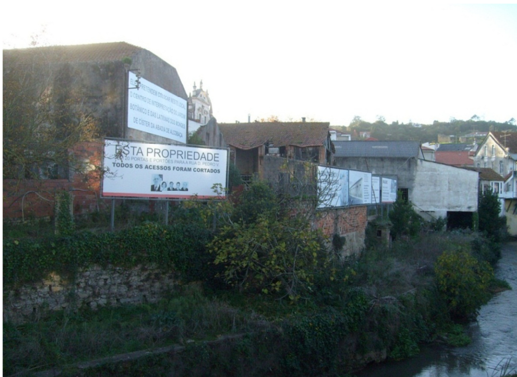
Fig.19 Vista sobre a área de intervenção e pré-existências
