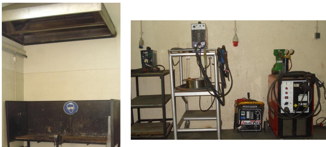
Figura 2.13 - Posto de soldadura e máquinas de soldar (TIG; MIG; eléctrodo revestido)
