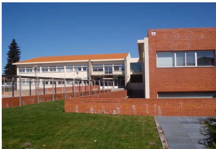
Figura 2.1 - Vista Geral da Escola
