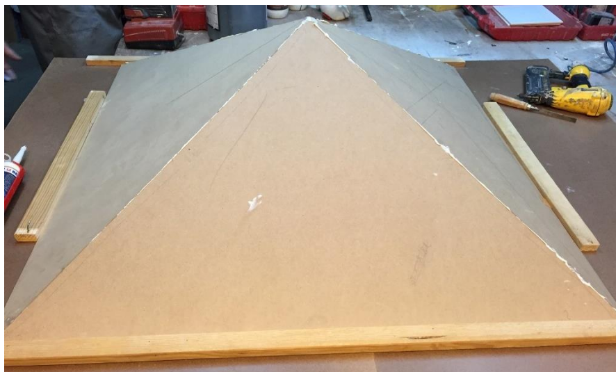
Figura 4.23 - Construção da parte superior do secador solar.
