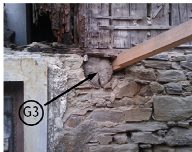
c) Apoio de viga G3
