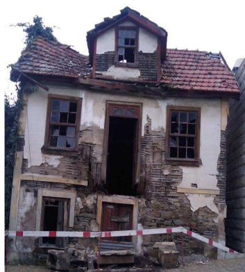
Figura 4.9 - Construção de tabique de referência
