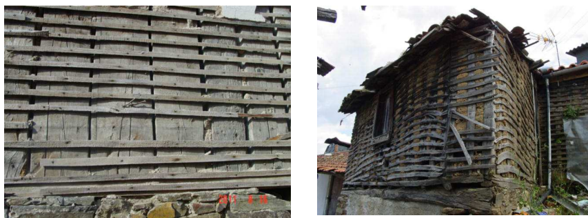
Figura 4.33 - Paredes de tabique
