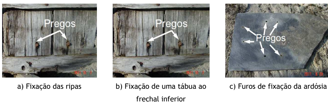
Figura 4.39 - Conexão entre elementos
