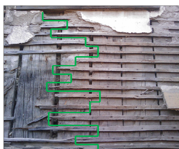
Figura 4.21 - Desalinhamento das emendas das ripas de uma parede exterior de tabique
