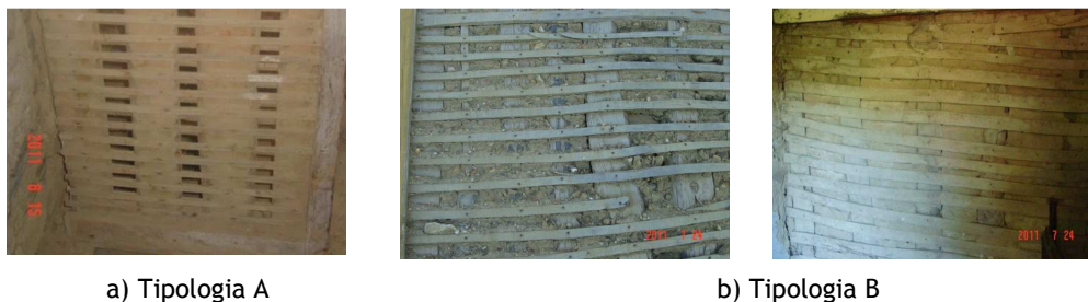
Figura 4.5 - Estrutura de madeira das paredes interiores de tabique
