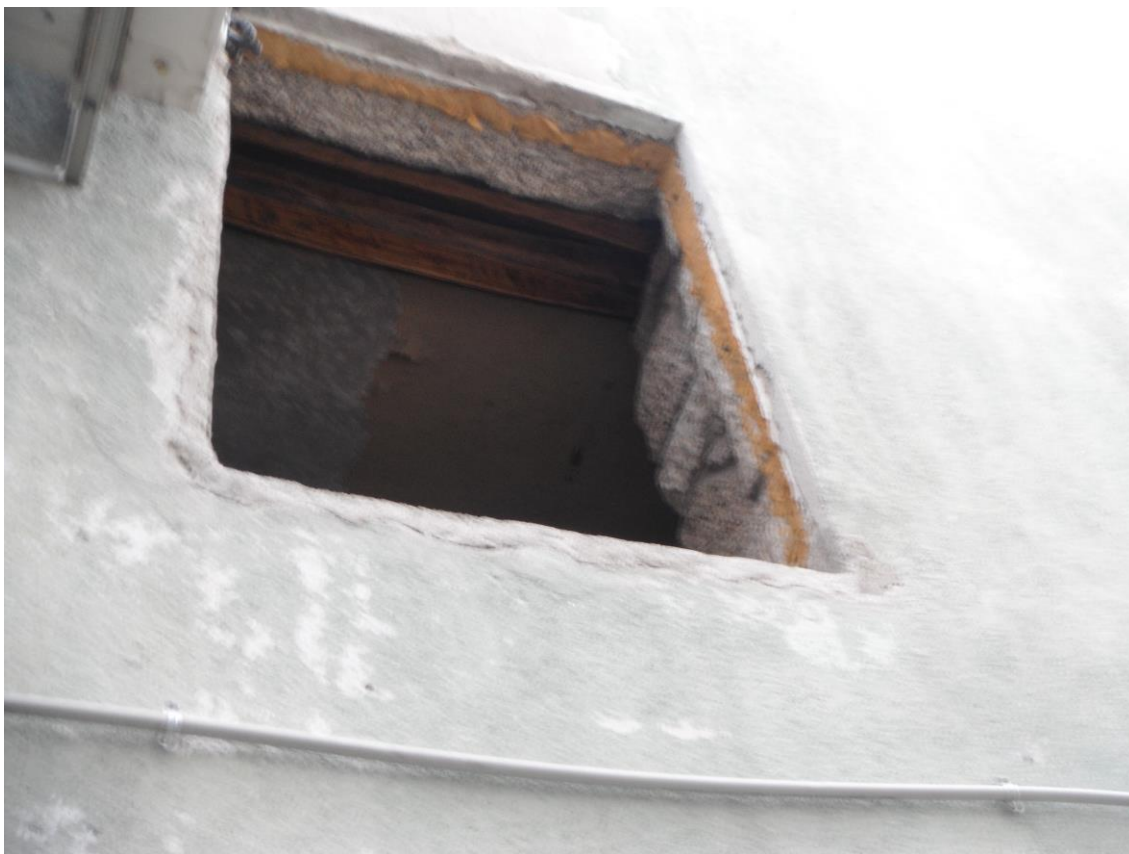
Figura 19: Janela da Pensão na Rua das Flores onde é possível observar como o novo material de isolamento reveste a fachada de pedra.
