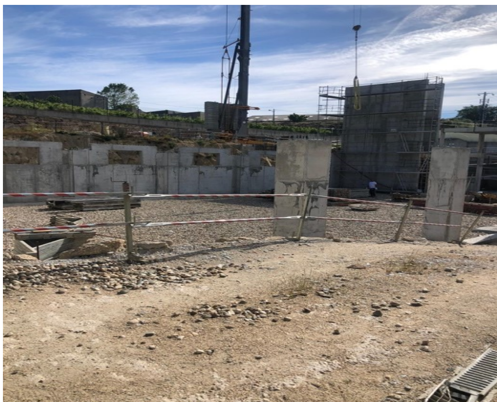
Figura 4.6 - Área em construção (foto tirada na visita do local em estudo).
