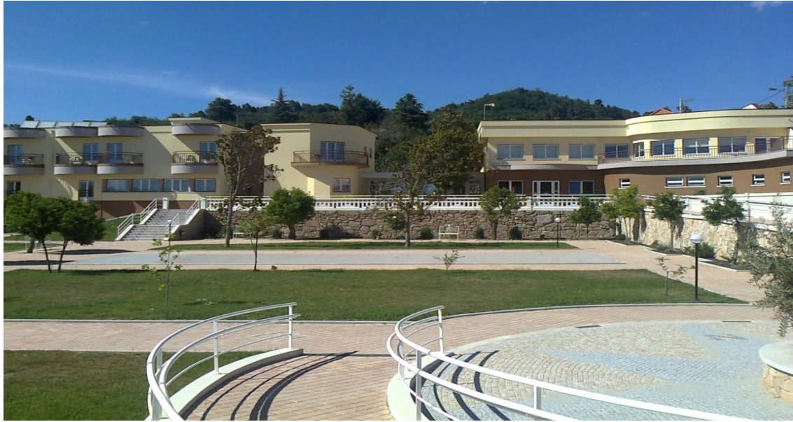
Figura 4.3 - Vista exterior dos dois blocos existentes e interligados, espaços verdes e pavimentos.
