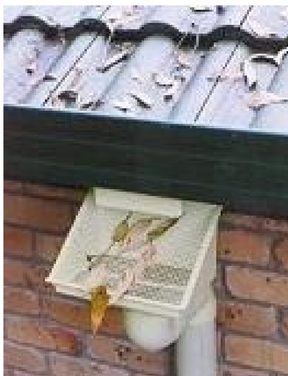
Figura 3.4 - Filtro no tubo de queda, da marca Leaf Eater (Abrantes, 2017).
