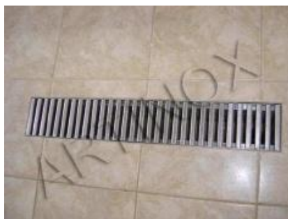
Figura 6 e 7 - Canaleta Sifónica com Saída Horizontal ( http://fotos.sapo.pt )
