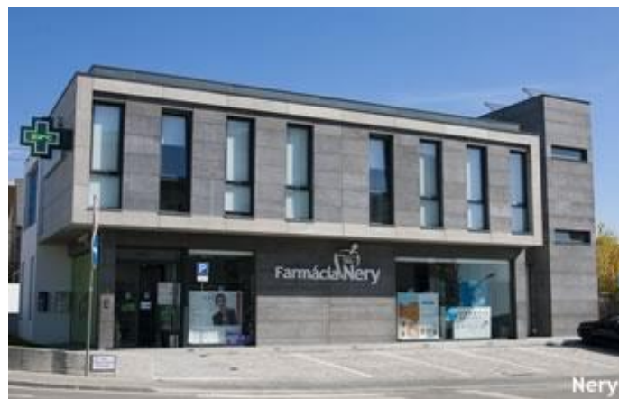
Figura 1. Aspeto exterior das instalações da Farmácia Nery [12].
