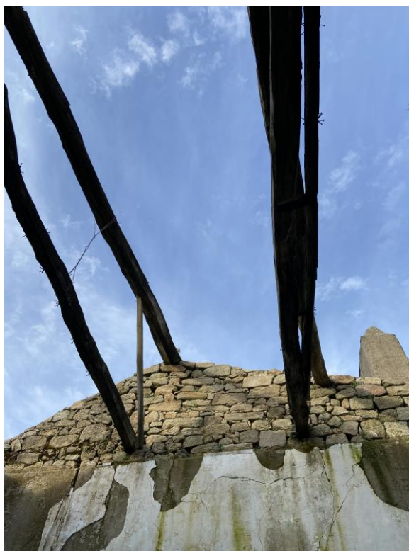
Figura 4 – Palácio Ducal – Vigas de madeira
