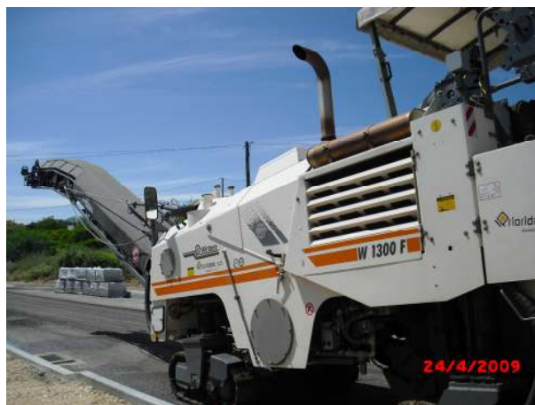
Figura 3. 5: Fresadora utilizada para a fresagem do pavimento.
