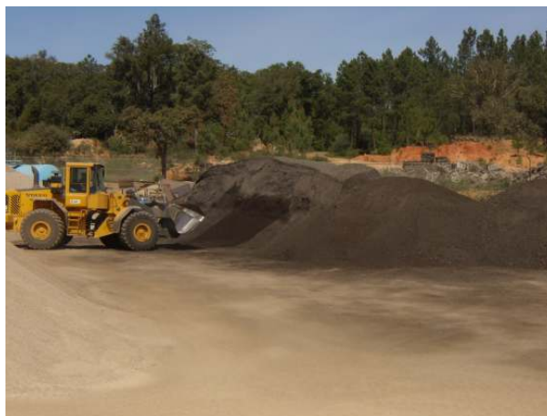
Figura 3. 3: Local de depósito do material fresado proveniente do pavimento existente.
