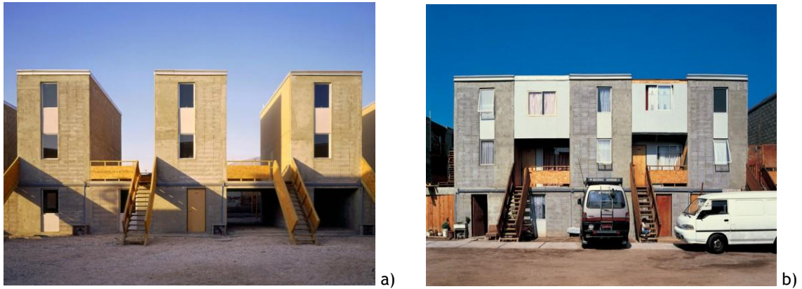
Fig. 10 - Quinta Monroy, ateliê Elemental, Iquique (Chile). a) antes; b) depois da ocupação
