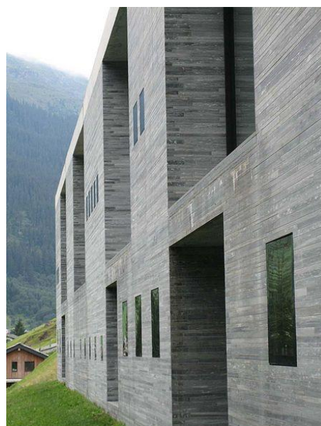
Fig. 15 – Fachada – Termas de Vals
