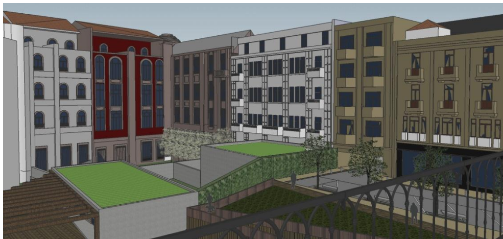
Figura 6.11 Coberturas verdes do edifício 20 e do anexo do edifício 7.
