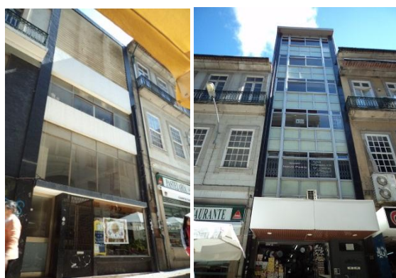
Figura 6.32 Fachadas dos edifícios 20 e 22.
