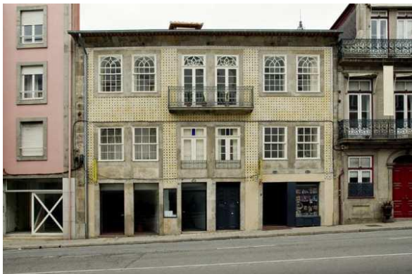
Figura 3.6 Edifício nº 170 na Rua D. Manuel II no Porto. 1º Prémio Nacional RECRIA 2007 (9ª Edição).
