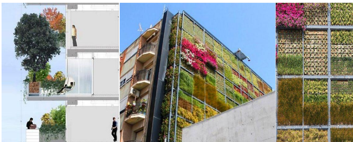
Figura 4.21 Exemplo de parede verde não estrutural num projecto em Milão e um exemplo de parede verde composta por sistemas modulares de variados tipos de plantas, num edifício de características tradicionais. Projecto de Jose Maria Chofre em São Vicente, Espanha.
