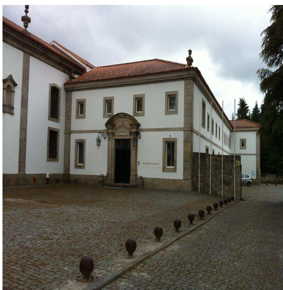
Figura 4. Fachada principal da Pousada
