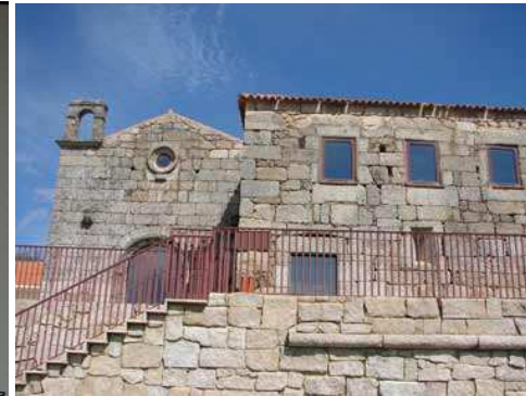
Figura g. Vista de acesso à piscina
