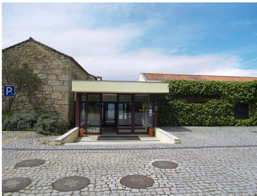
Figura 16. Imagem da fachada principal da Pousada de Belmonte
