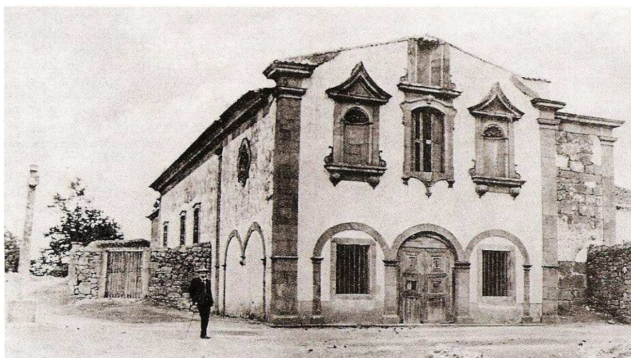
Figura 27. Postal do início do séc. XX, em que já é visível a degradação em que se encontrava o convento [25]
