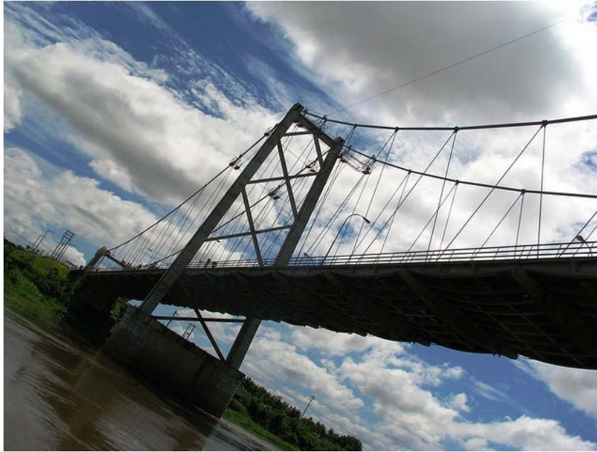
Figura 3.2 - Aspectos gerais/enquadramento da ponte (vista inferior da ponte), http://www.panoramio.com . 21-05-11 16:49.
