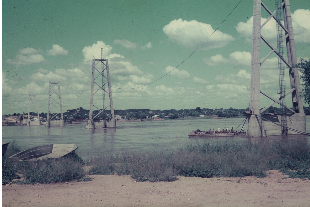
Figura 3.3 - Aspectos gerais/enquadramento da ponte (vista das torres), http://www.panoramio.com . 21-05-11 16:52.
