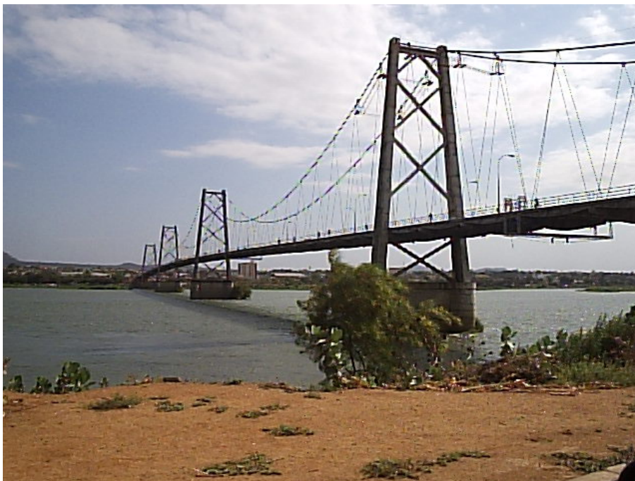
Figura 3.1 - Aspectos gerais/enquadramento da ponte (vista longitudinal), http://www.panoramio.com . 21-05-11 16:41.
