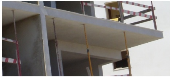
Figura 3 - Edifício com varandas [4]
