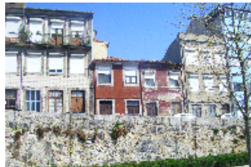
Imagem 18: Fachadas dos edifícios a intervir (a vermelho, ao centro), Porto, 2009
