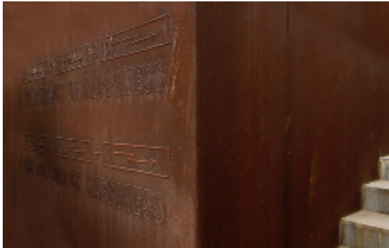
Imagem 21: Intervenção do artista plástico Michael Biberstein na parede de aço corten da piscina. Casa Julião Sarmento, Arquitecto Carrilho da Graça, 2009, Fonte11
