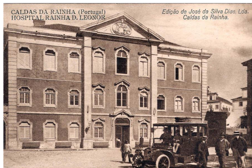
Figura 4 - Hospital Termal, Caldas da Rainha.
