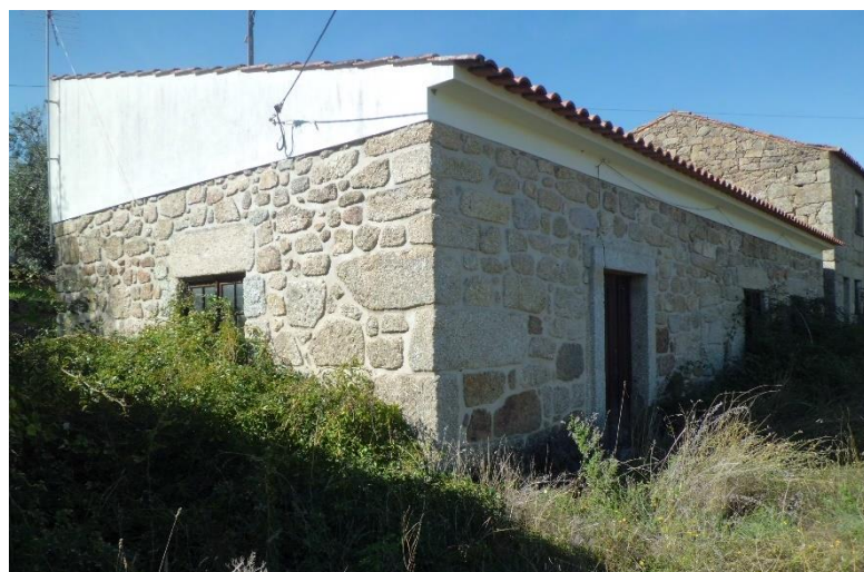
Figura 37 - Edifício reabilitado pela Junta de Freguesia de Alpedrinha.
