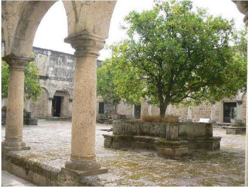
Figura 15 – Intervenção no claustro do Convento.
