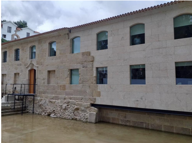
Figura 25 - Fachada de entrada, em que se pode ver o que é novo e o que é antigo.
