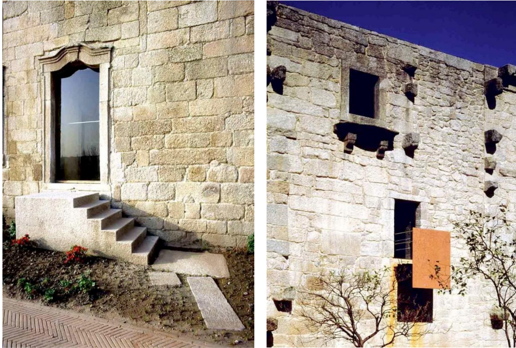
Figura 13 e 14 -Pormenor de intervenções novas assumidas pelo arquiteto.
