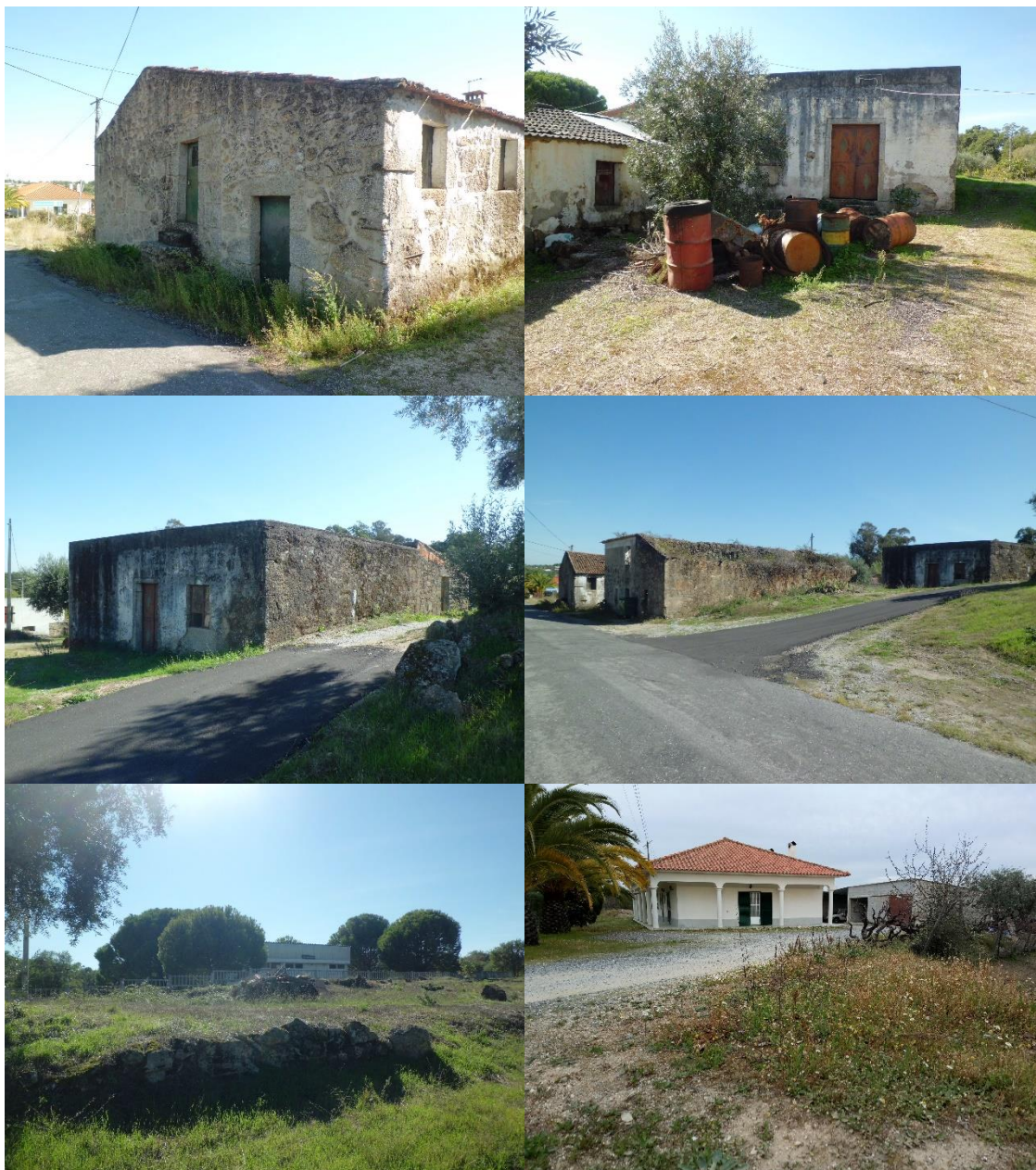
Figura 38 - Fotos dos vários edificados em torno das Termas da Touca.
