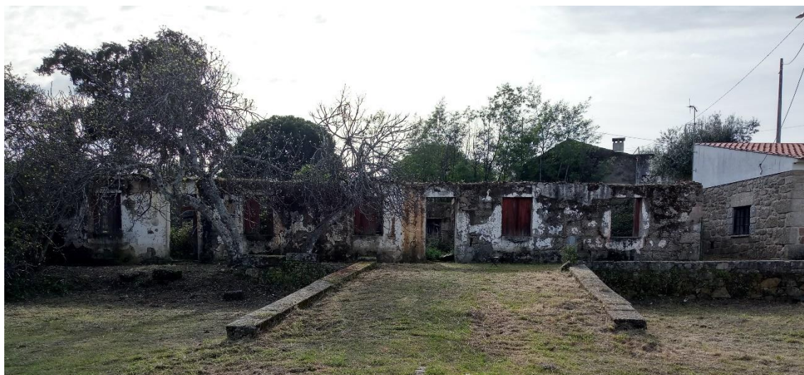
Figura 36 - Edifício de apoio ao balneário das Termas da Touca.
