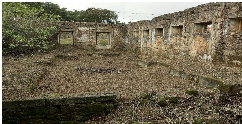
Figura 35 - Vista interior do Balneário das Termas da Touca, onde pudemos observar o tanque e as várias banheiras esculpidas de granito.
