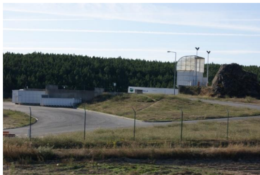
Figura 31 - Centro de Transferência de Lixos do Sabugal
