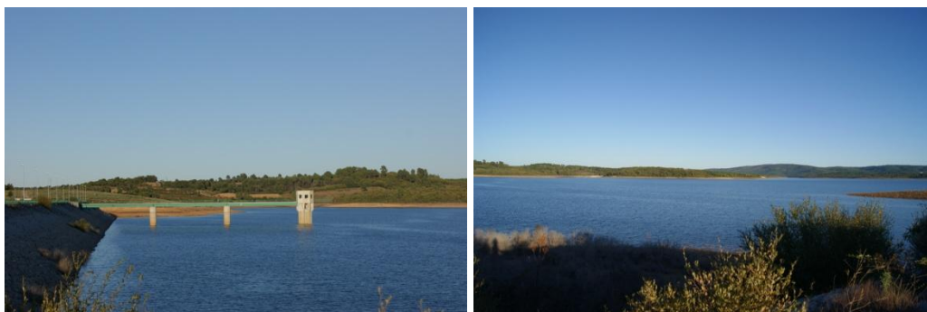
Figura 6 e 7 - Barragem do Sabugal
